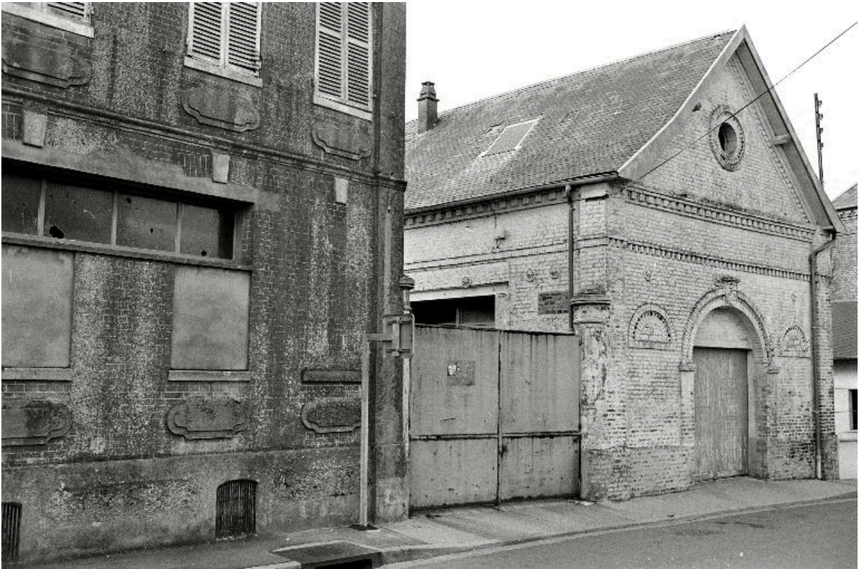
Vue de l'ancien entrepôt de marchand de vins transformé en atelier, en 1990.
