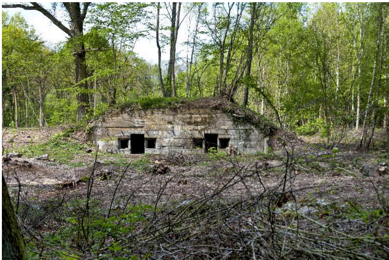
Élévation antérieure, vers le nord-ouest
