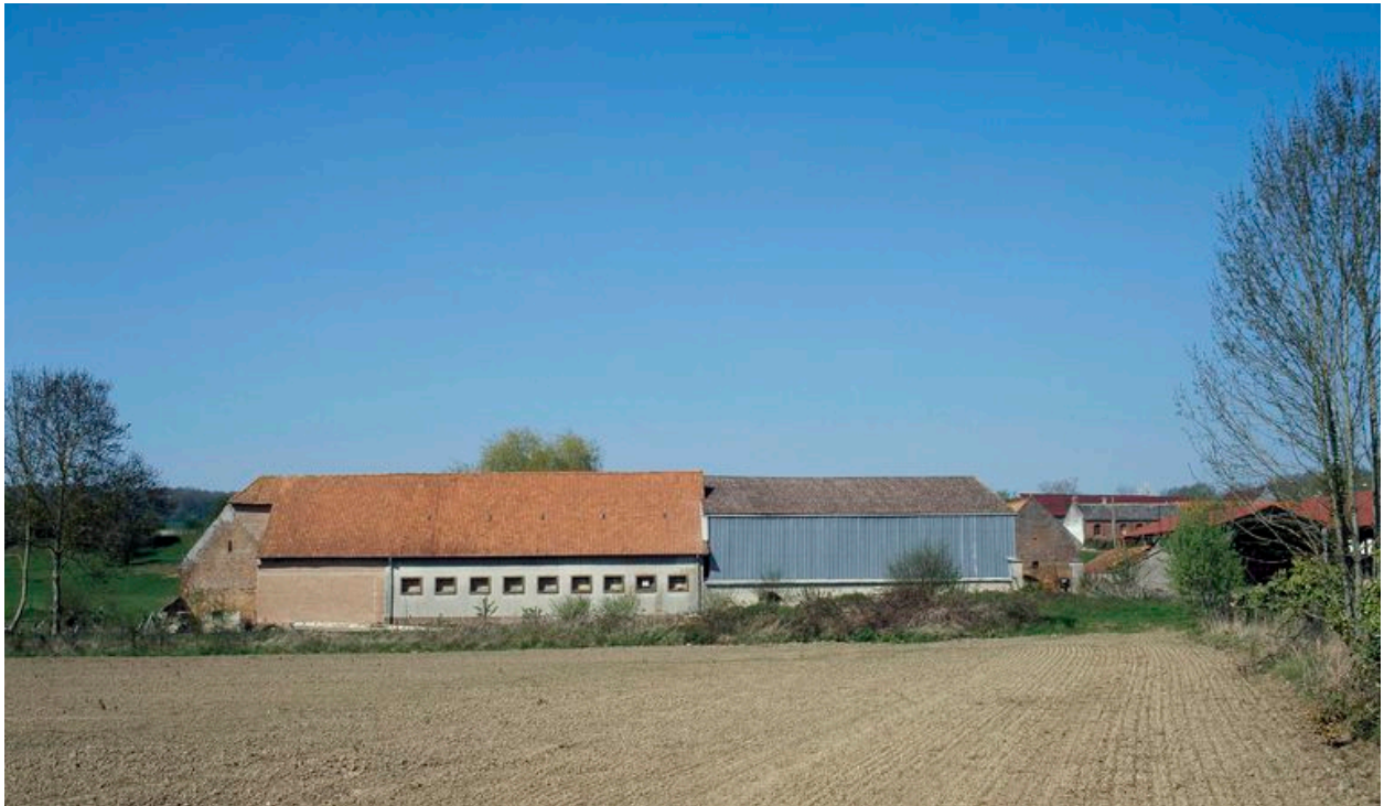
Vue générale depuis le sud.
