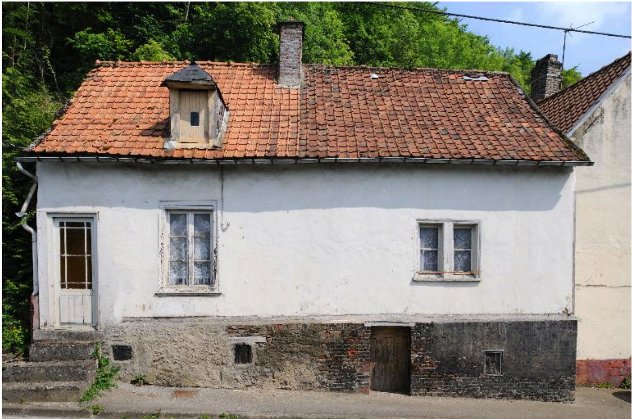
Façade sur rue, vue de face.
