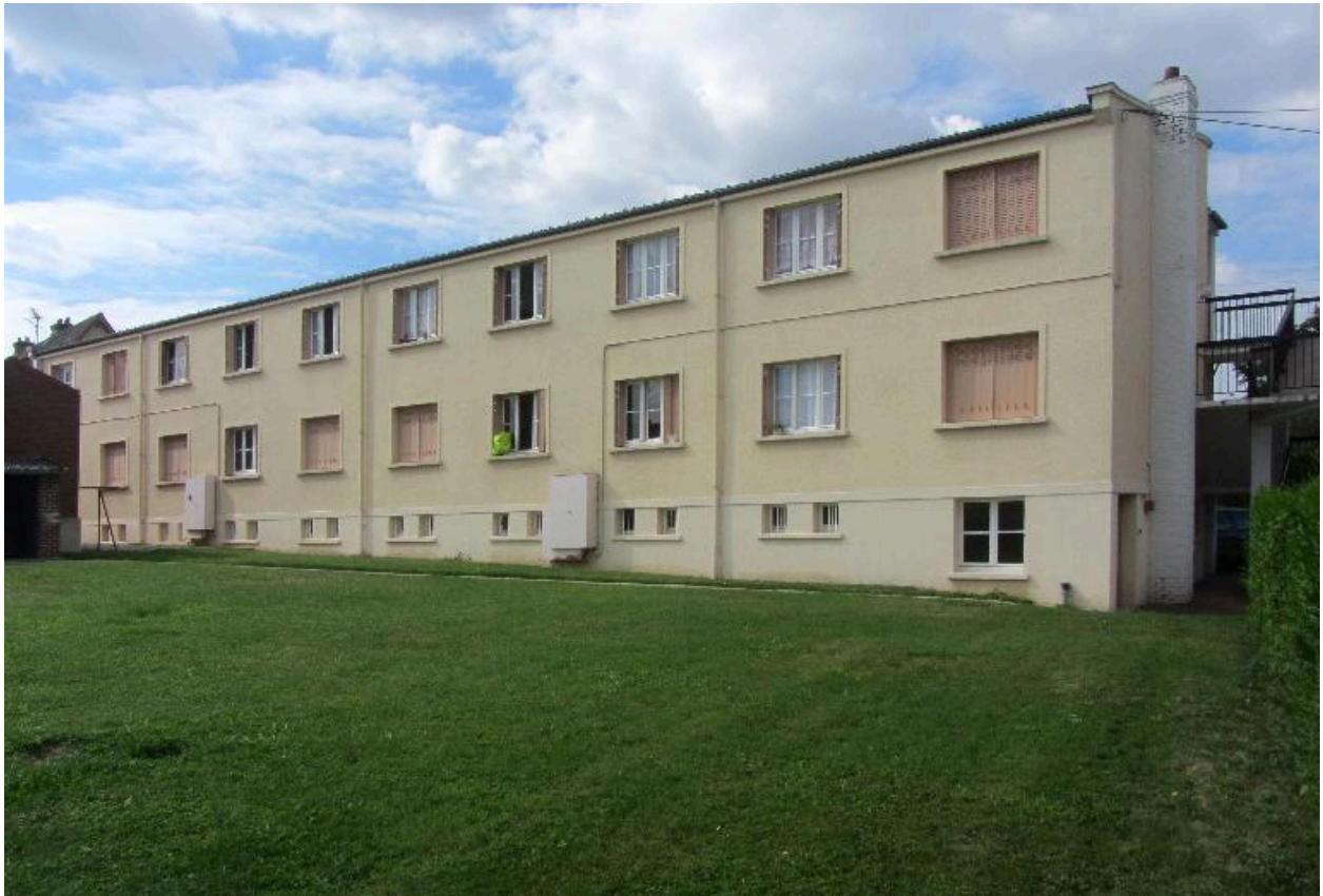
Immeuble des célibataires et saisonniers de l'entreprise, façade postérieure, sur jardin.
