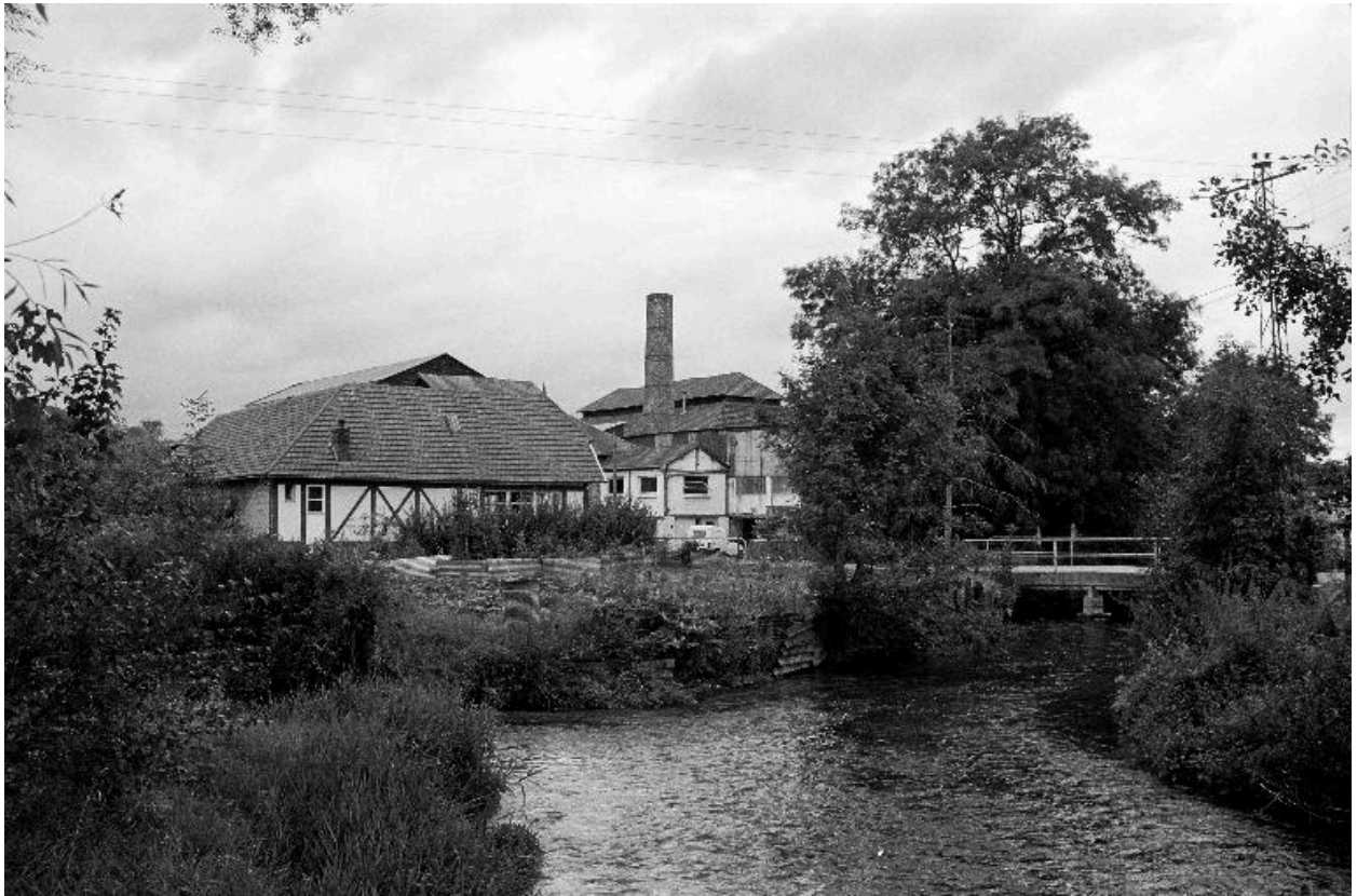
Atelier de fabrication, vue partielle, flanc nord-est.
