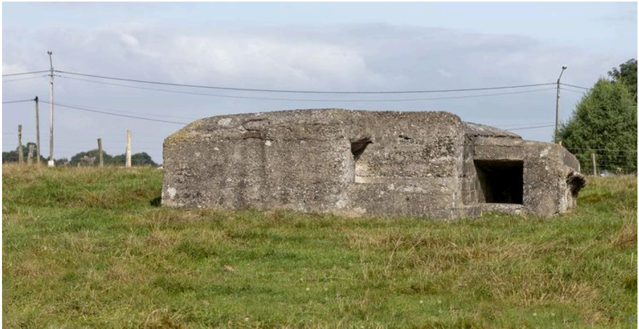
Vue vers le nord. En face l'ouverture du toboggan casematé
