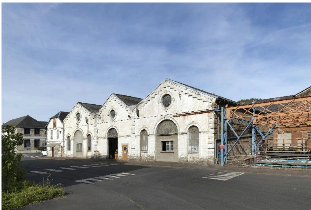
L'atelier de mécanique, vue d'ensemble est.
