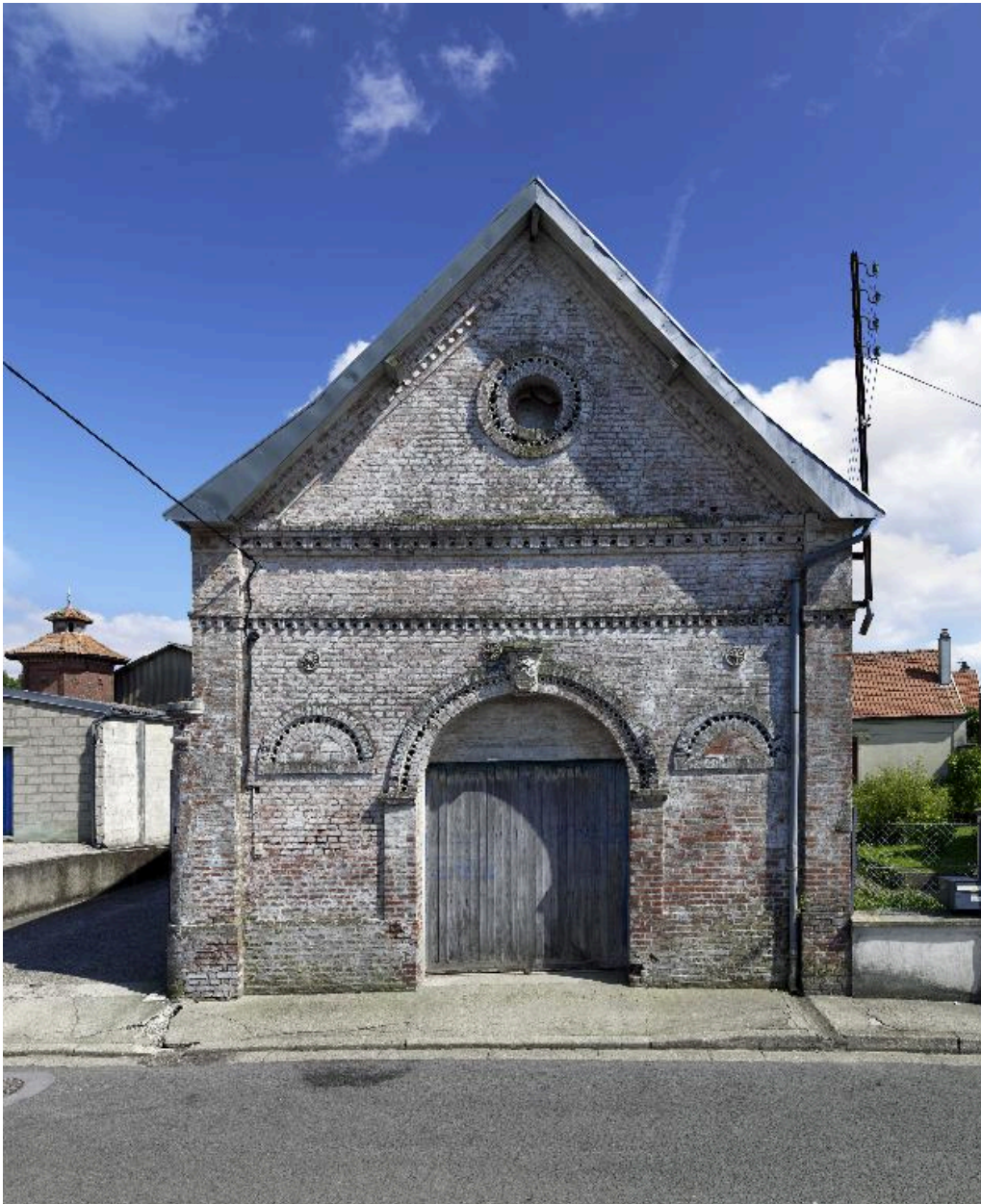
Vue du pignon de l'entrepôt de l'ancien marchand de vins.
