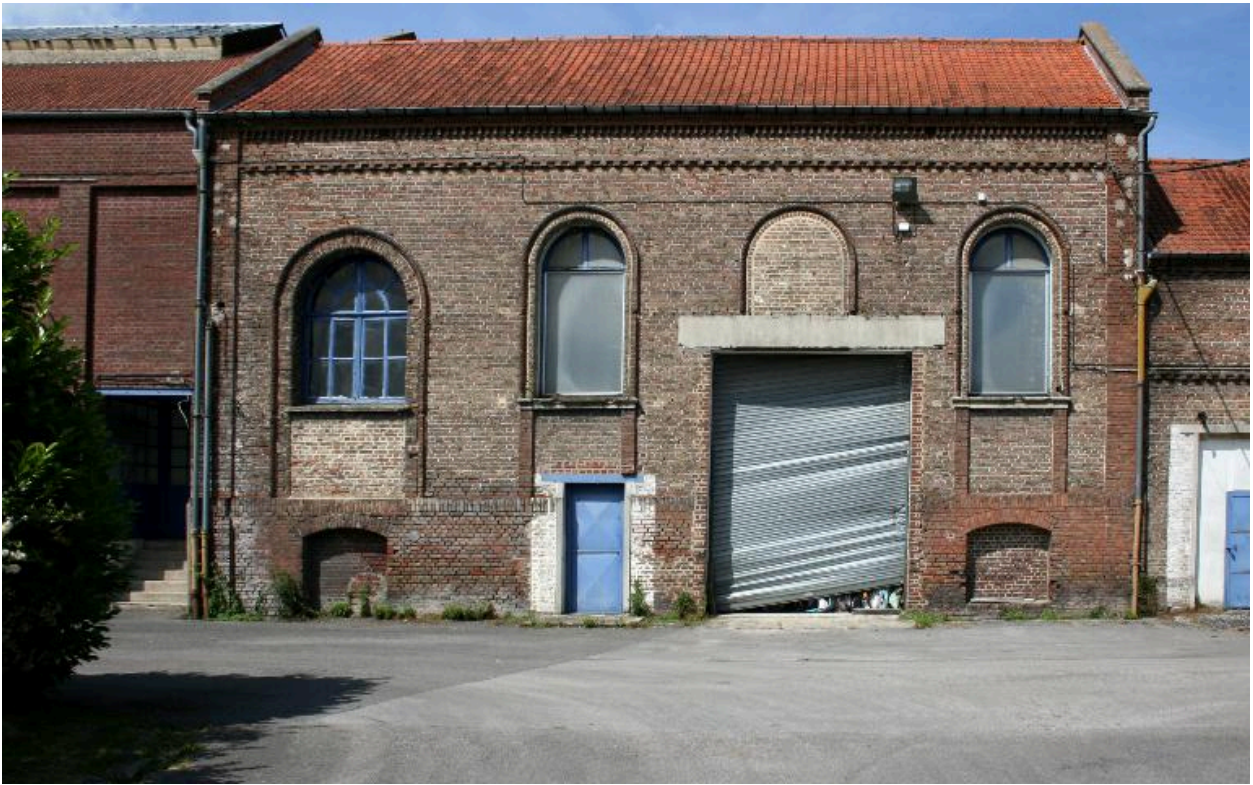
Façade sud de la salle des générateurs.
