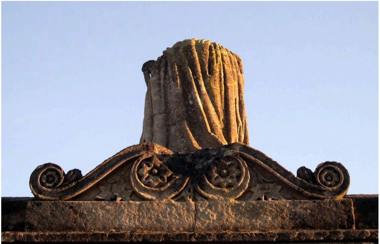
Vue de détail du couronnement, face nord.
