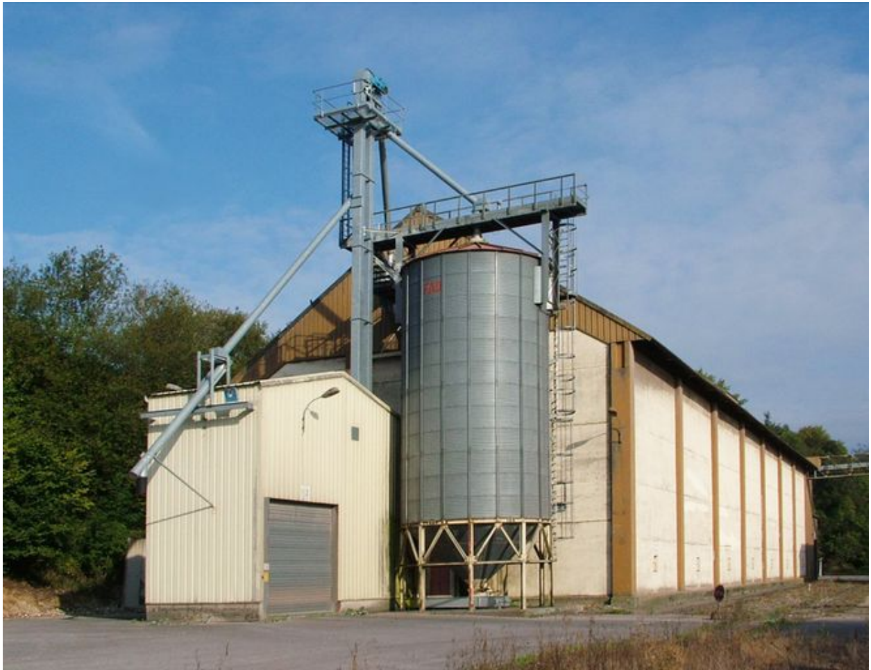
Vue du silo situé de l'autre côté de la voie ferrée.
