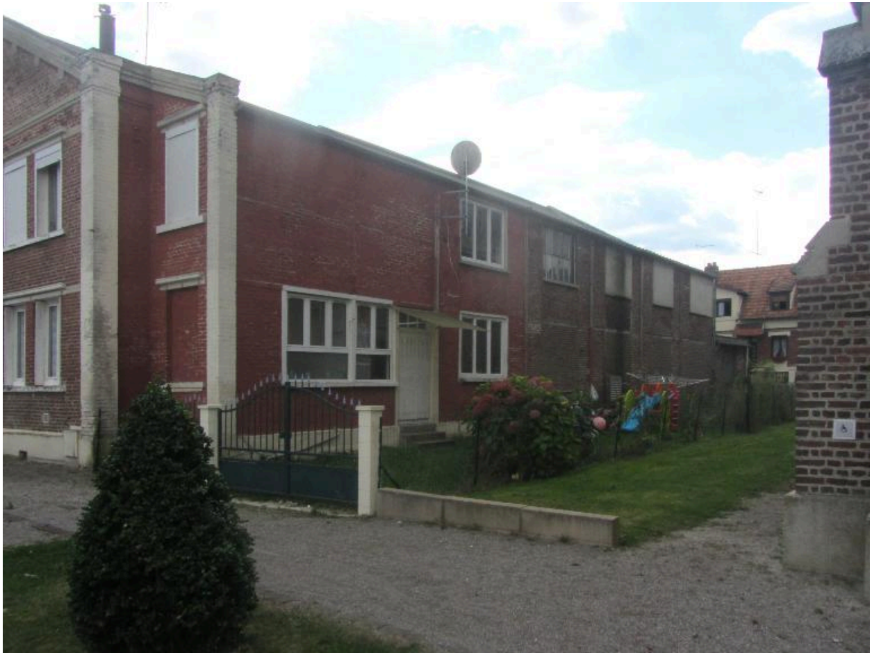
Vue de la façade nord.
