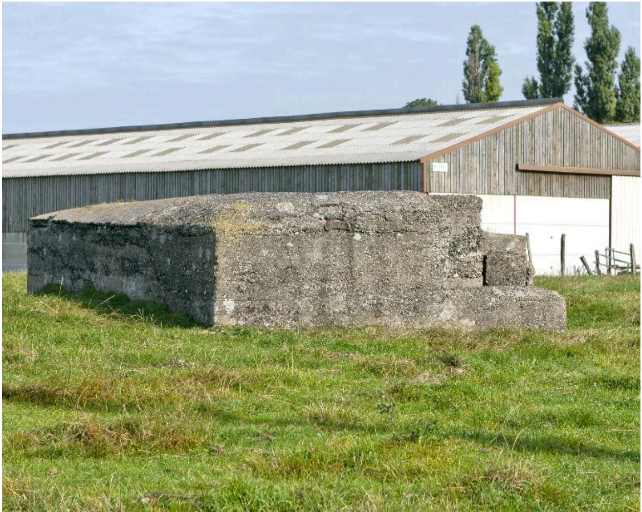
Vue vers le nord-est
