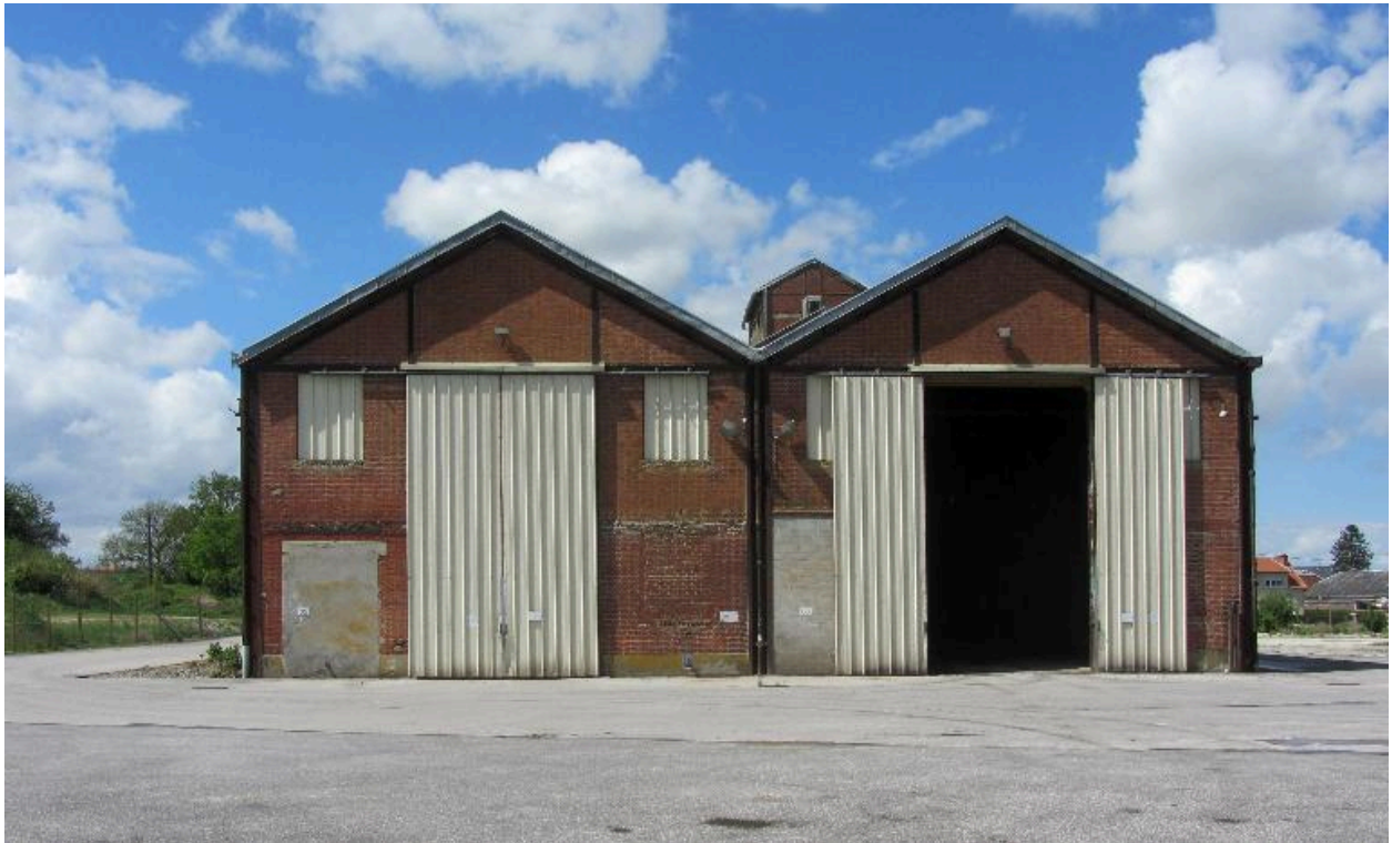
Façade est de la râperie.
