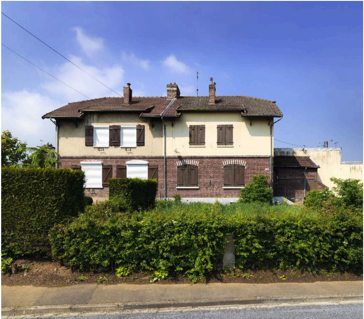
Maison de type B, à quatre unités d'habitation (8-10 rue Pasteur).
