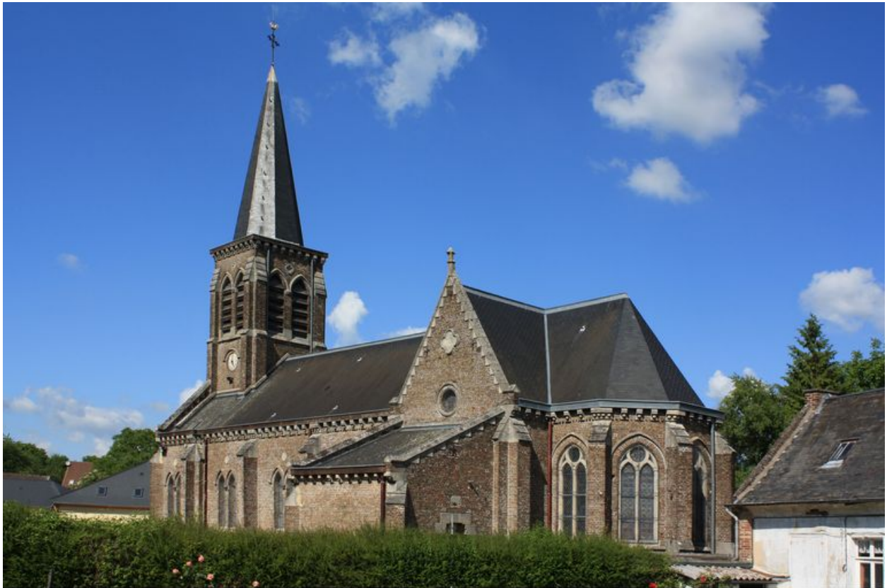
Vue d'ensemble sud-est de l'église.
