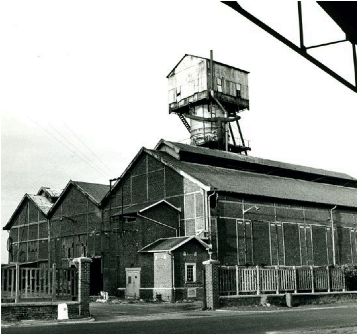
Atelier de fabrication et four à chaux.
