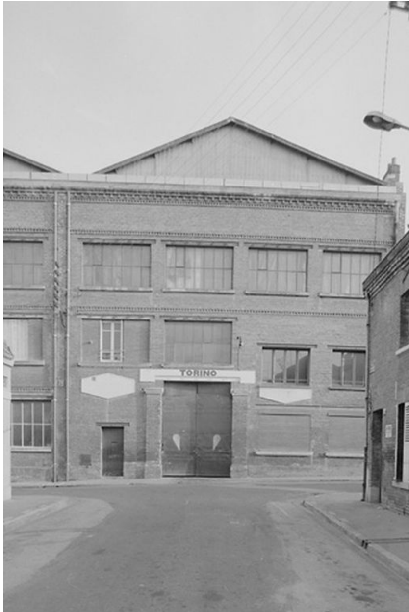
Atelier de fabrication, élévation antérieure.
