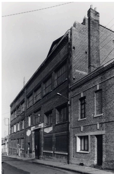
Vue générale. Phot. Thierry Lefébure IVR22_19888000733Z
