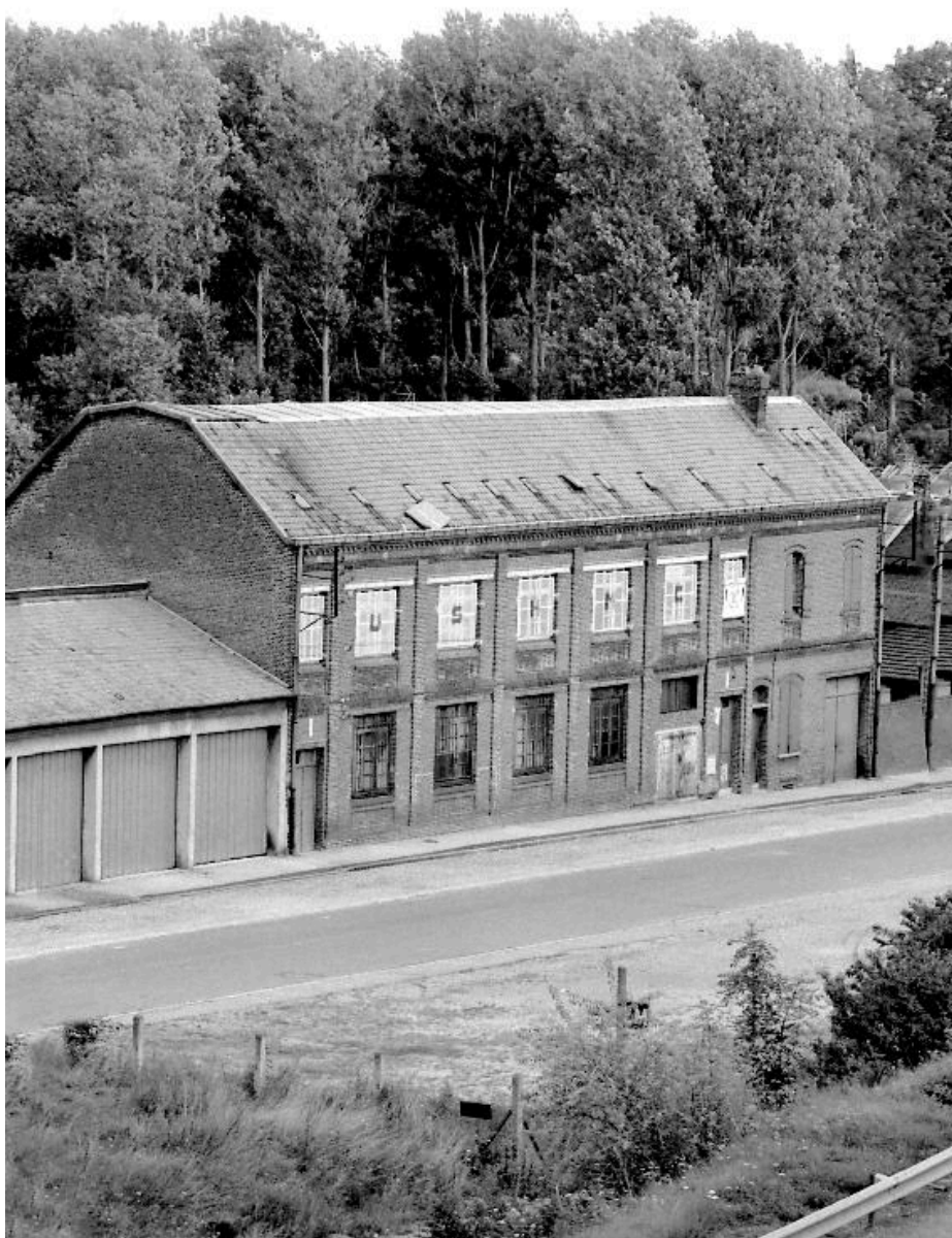
L'ancien laboratoire (?). Vue depuis le sud-ouest.
