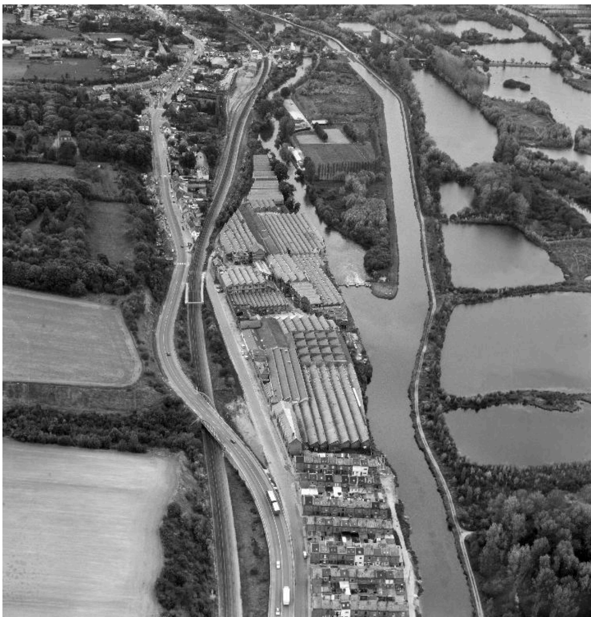
Vue aérienne, flanc sud-est.
