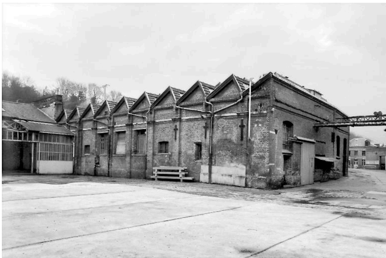
Atelier de réparation mécanique.
