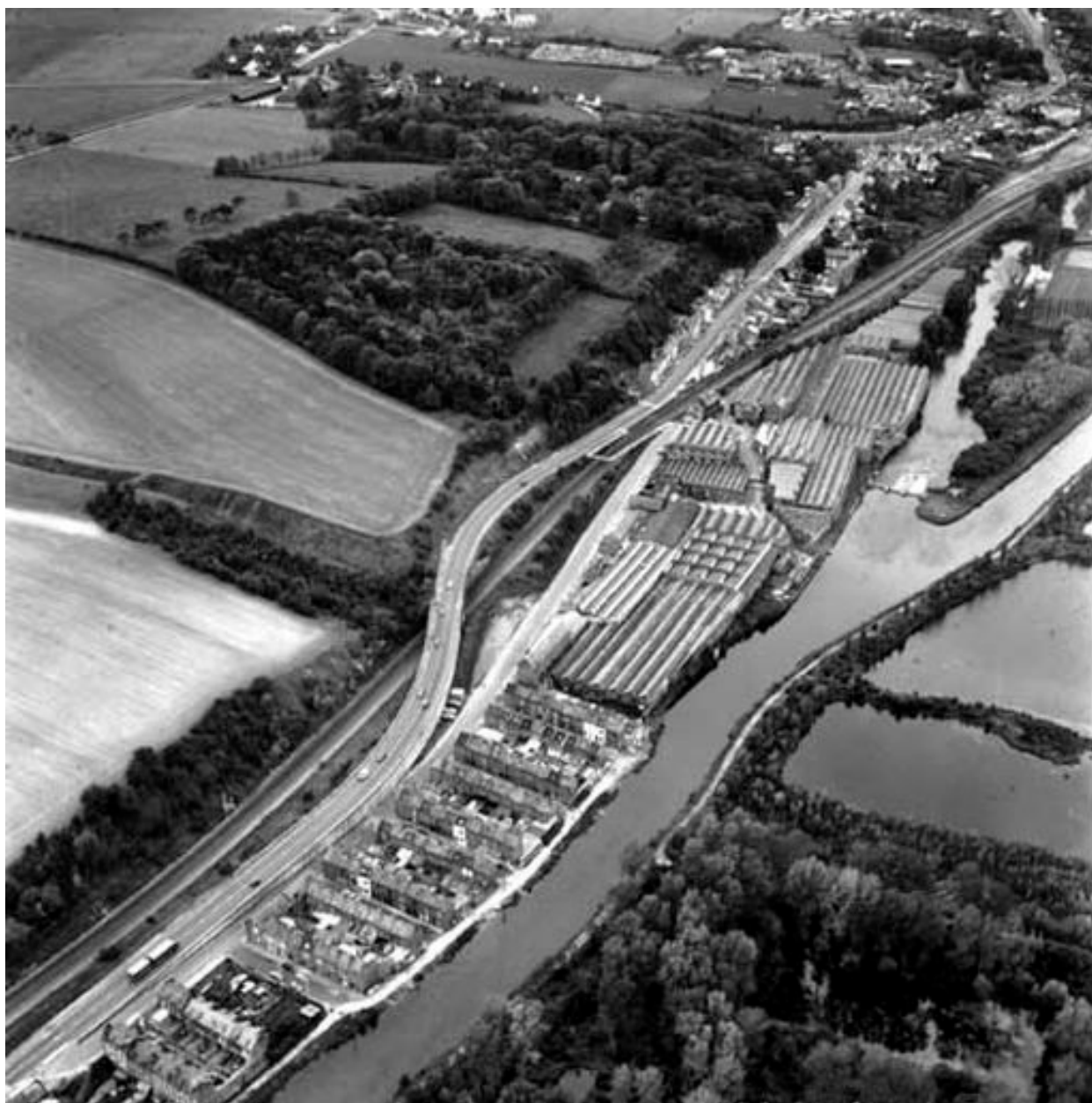
Vue aérienne, flanc sud-ouest.
