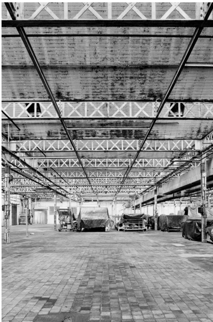
Atelier de fabrication (préparation filature). Intérieur.
