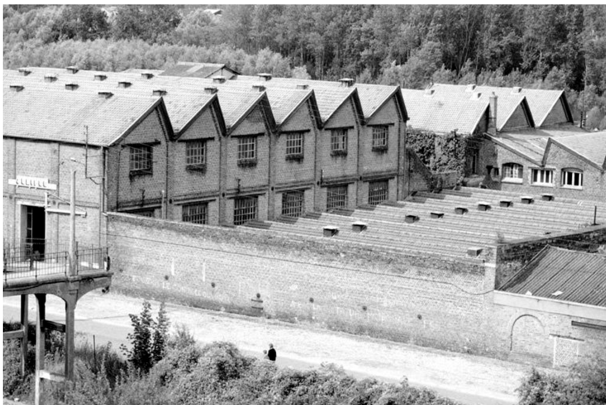
Vue des parties centrales de l'usine
