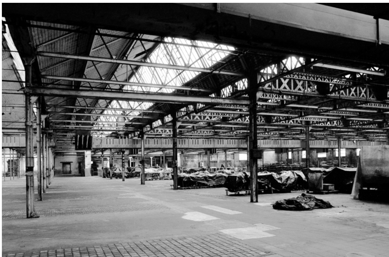
Atelier de fabrication (préparation filature). Intérieur.
