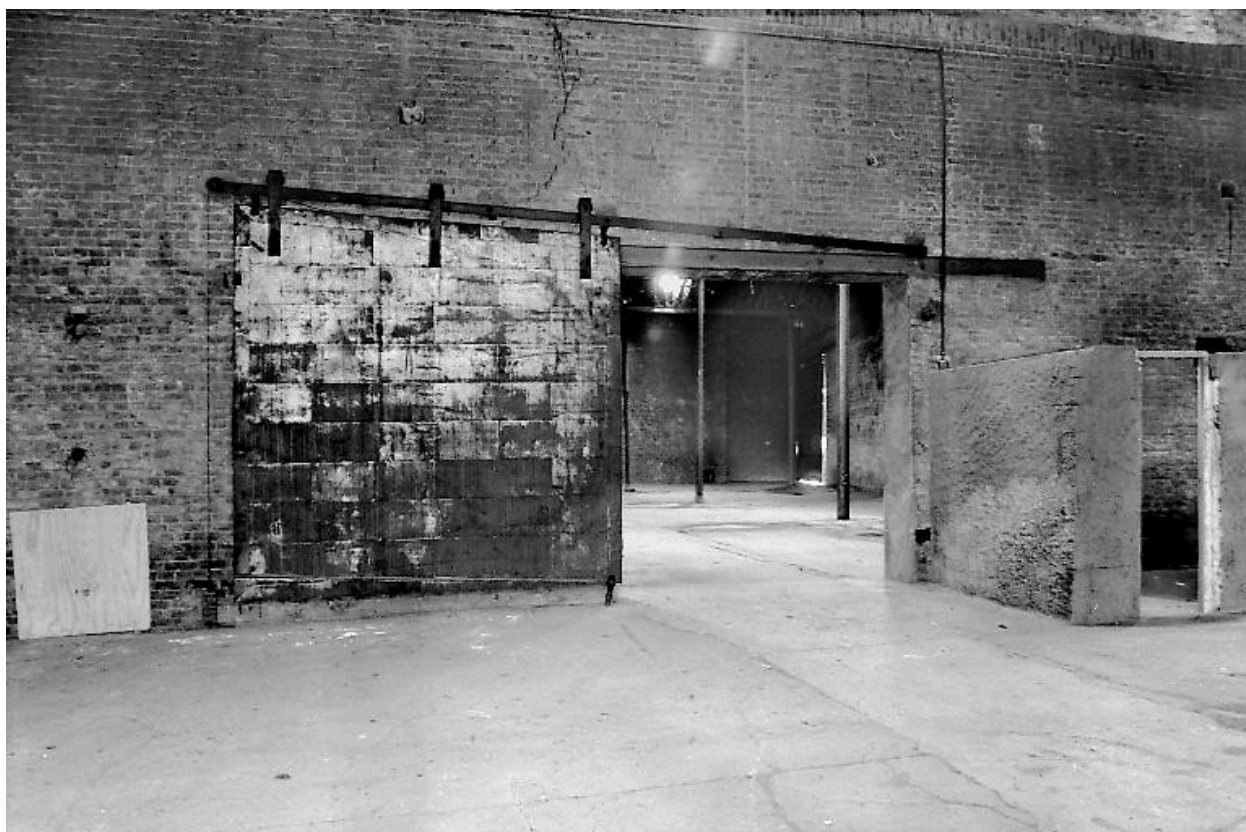
Entrepôt industriel. Vue intérieure. Porte inifugée.
