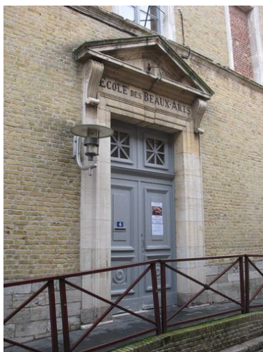
Façade sur rue : portail Phot. Bruno Decrock IVR31_20106208271NUCA
