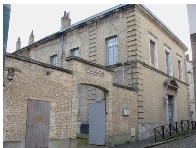
Façade et entrée sur rue Phot. Bruno Decrock IVR31_20106208269NUCA
