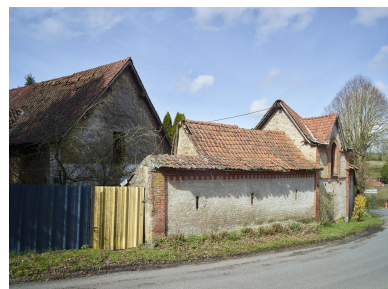
Vue partielle des bâtiments agricoles. Phot. Pierre Thibaut IVR32_20256200464NUCA
