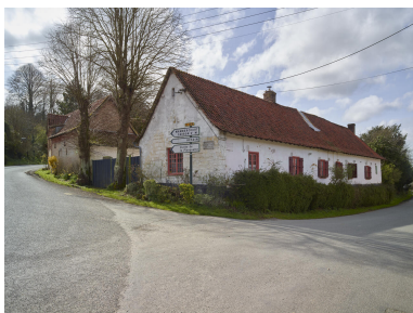
Vue de trois quarts du logis. Phot. Pierre Thibaut IVR32_20256200466NUCA
