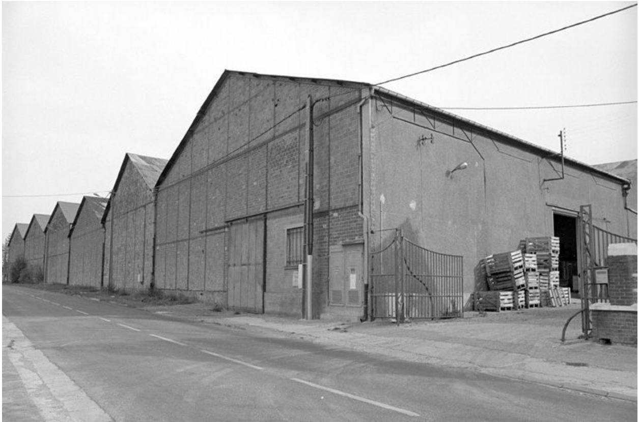
Atelier de fabrication, vue partielle.
