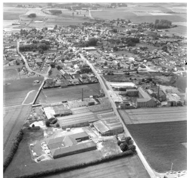
Vue aérienne, flanc est. Phot. Phot'R IVR22_19888001291P
