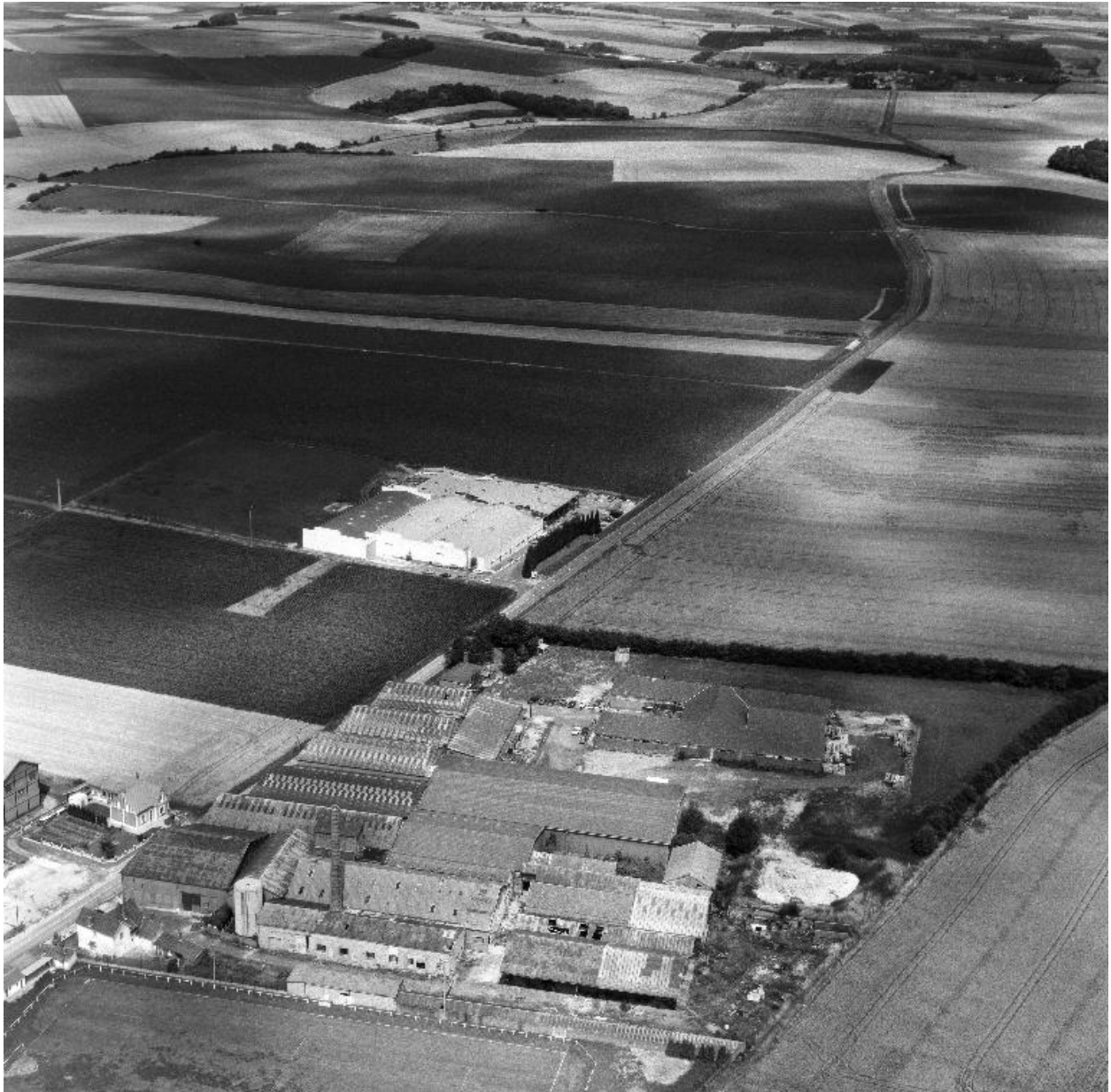
Vue aérienne, flanc sud-ouest.
