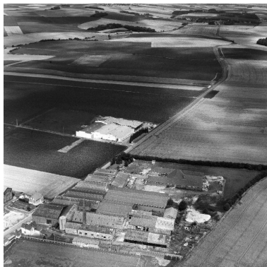
Vue aérienne, flanc sud-ouest. Phot. Phot'R IVR22_19888001292P
