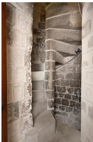
Vue de l'escalier à vis desservant les différents étages du beffroi. Phot. Marc Kérignard IVR32_20258001119NUCA
