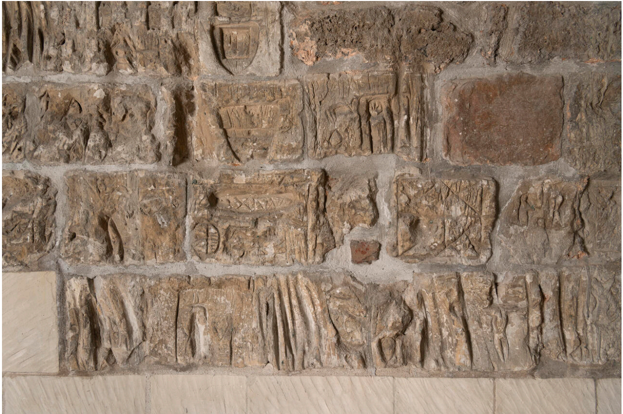
Détail d'un mur présentant des graffiti.
