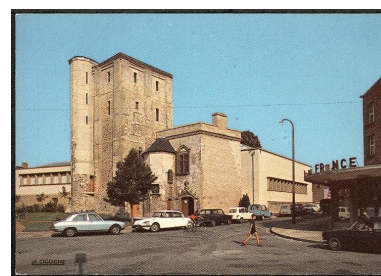
Le beffroi avant la reconstruction de la toiture, carte postale, vers 1980 (BM Abbeville ; fonds de cartes postales CP ABB 03-0163). Repro. Bibliothèque municipale d'Abbeville IVR32_20168005176NUCA
