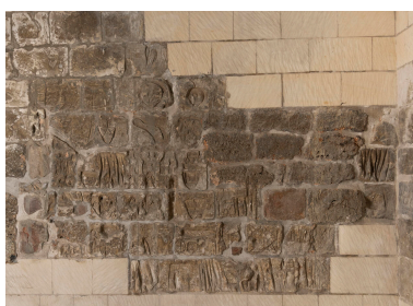
Mur présentant des pierres du XIIe siècle gravées de graffiti, ainsi que des pierres témoignant des restaurations effectuées après la Seconde Guerre mondiale. Phot. Marc Kérignard IVR32_20258001122NUCA
