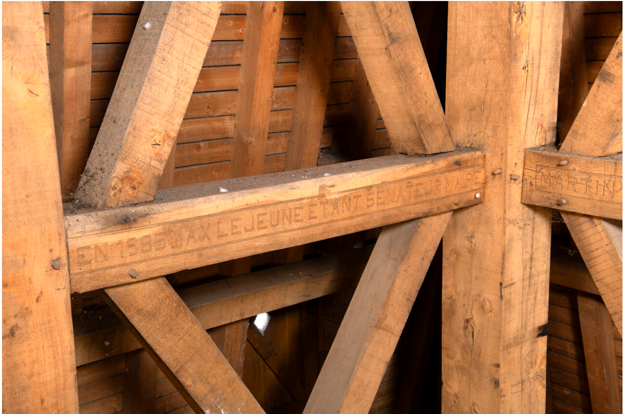
Détail de la charpente avec la première partie de l'inscription.
