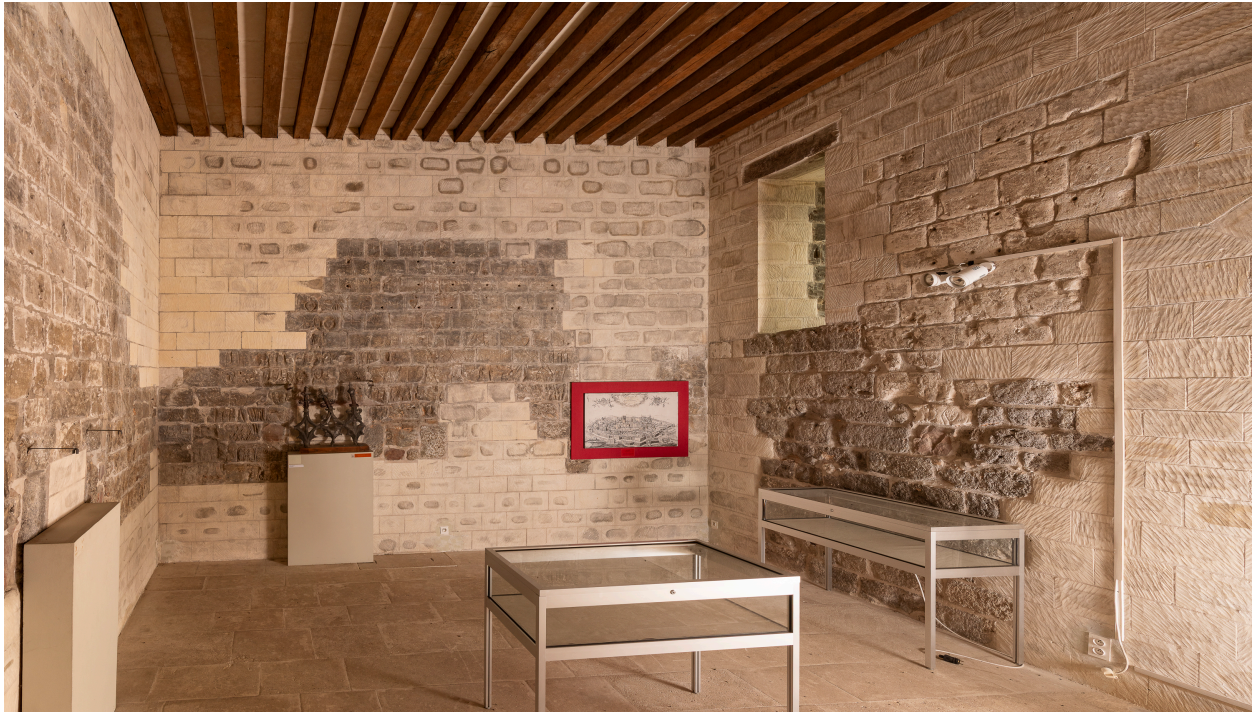
Vue générale de la salle haute.
