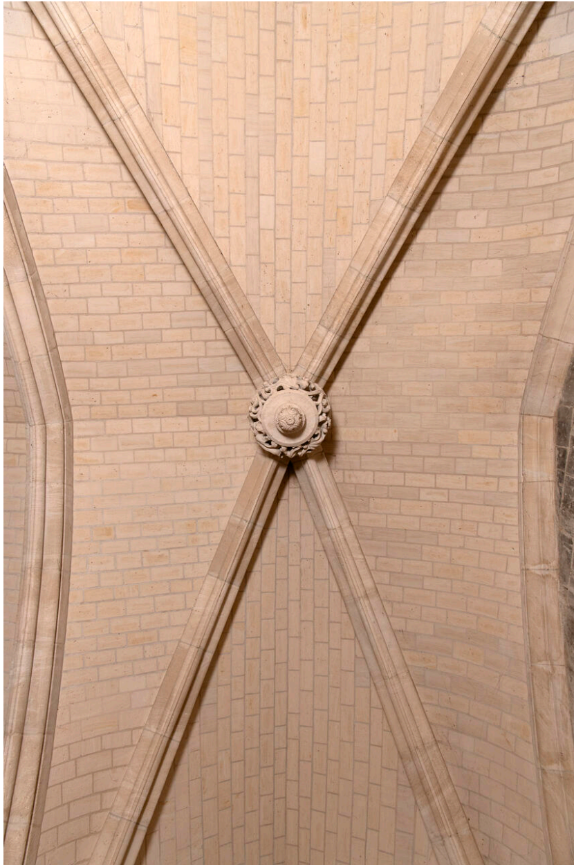
Détail d'une clef de voûte de la salle de la Trésorerie.
