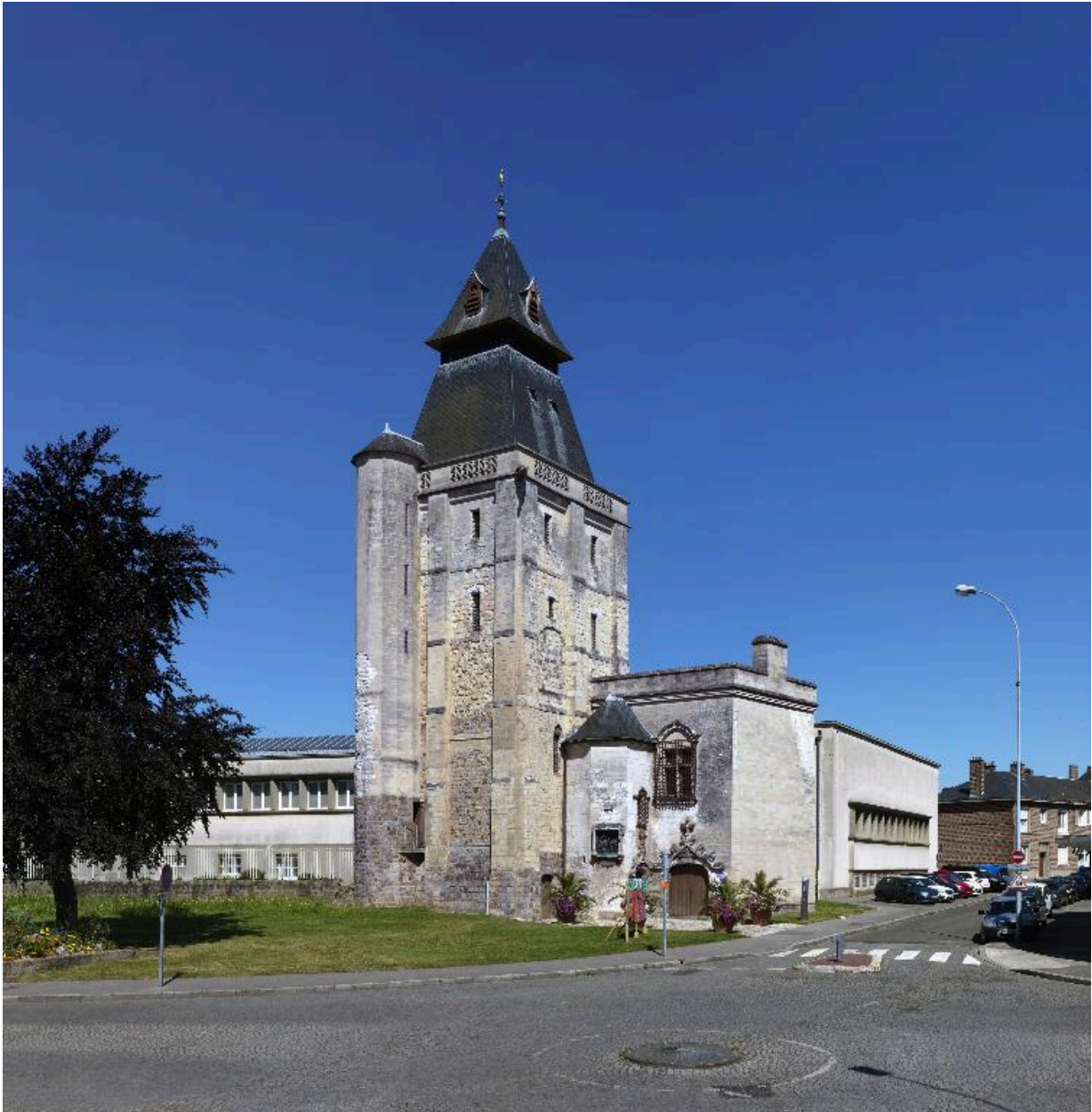
Vue générale du beffroi.
