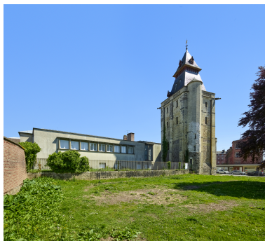
Vue du beffroi et du musée Boucher-de-Perthes. Phot. Thierry Lefébure IVR32_20258001092NUCA
