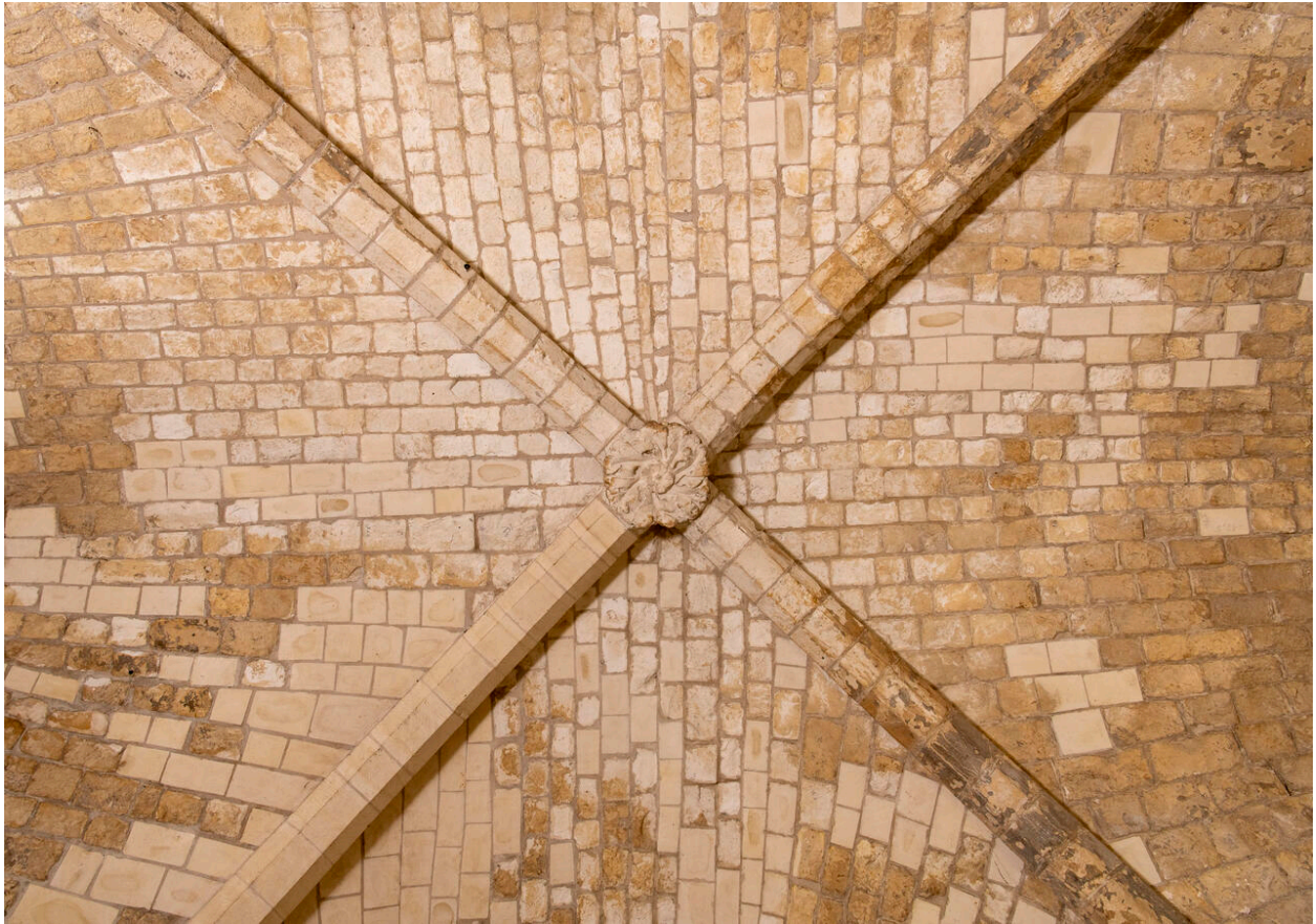
Détail de la clef de voûte de la salle basse.
