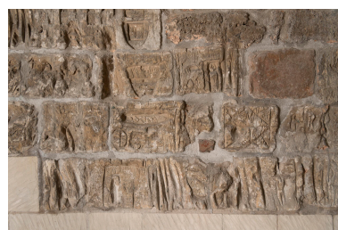
Détail d'un mur présentant des graffiti. Phot. Marc Kérignard IVR32_20258001124NUCA
