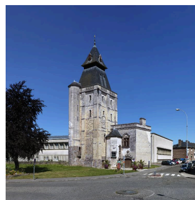
Vue générale du beffroi. Phot. Thierry Lefébure IVR32_20168000284NUC2A
