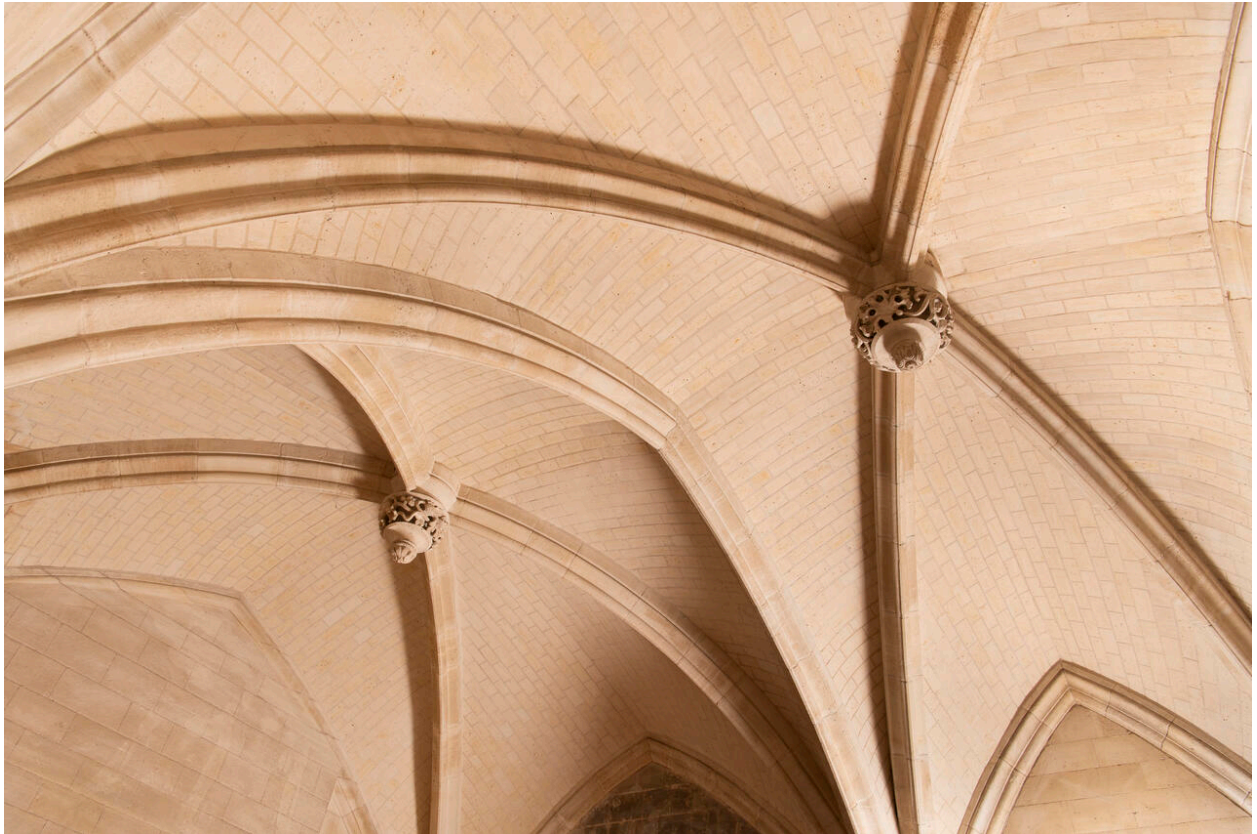
Vue des voûtes de la salle de la Trésorerie.
