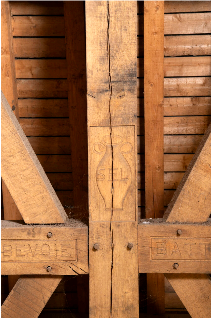
Détail de la charpente avec la signature sous forme de rébus de l'architecte François Vasselle.
