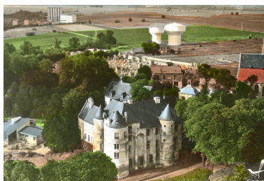
Construction d'une maison pour la société Usinor dans le parc du château de Montataire, début 1970 (AC Montataire). Phot. Clarisse Lorieux IVR22_20086005095NUCAB
