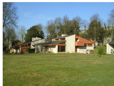
Logements construits à l'emplacement des jardins du château à partir de 1964. Phot. Clarisse Lorieux IVR22_20086005000NUCA
