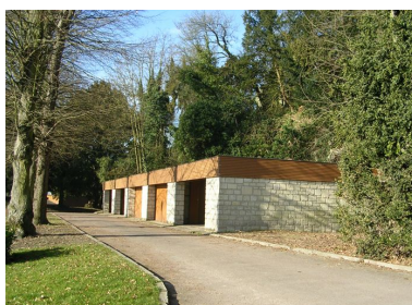
Garages de la cité. Phot. Clarisse Lorieux IVR22_20086005002NUCA
