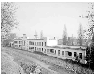
Façade arrière, vue générale, état en 2001 avant réhabilitation. Phot. Pierre Thibaut IVR31_20015900937V
