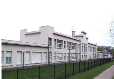
Façade arrière, vue générale, état en 2005 après réhabilitation en logements. Phot. Olivier Liardet IVR31_20065906161NUCA
