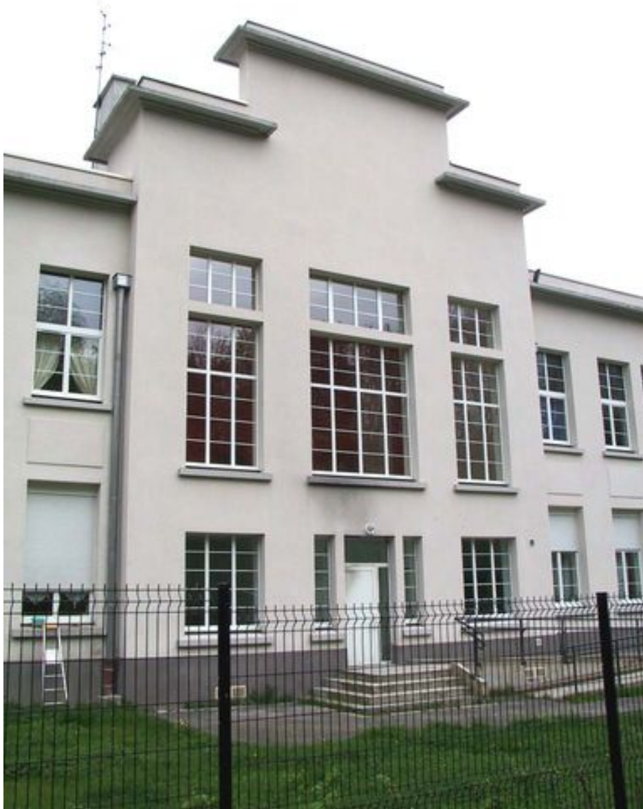
Façade arrière, vue partielle (avant-corps central), état en 2005 après réhabilitation.
