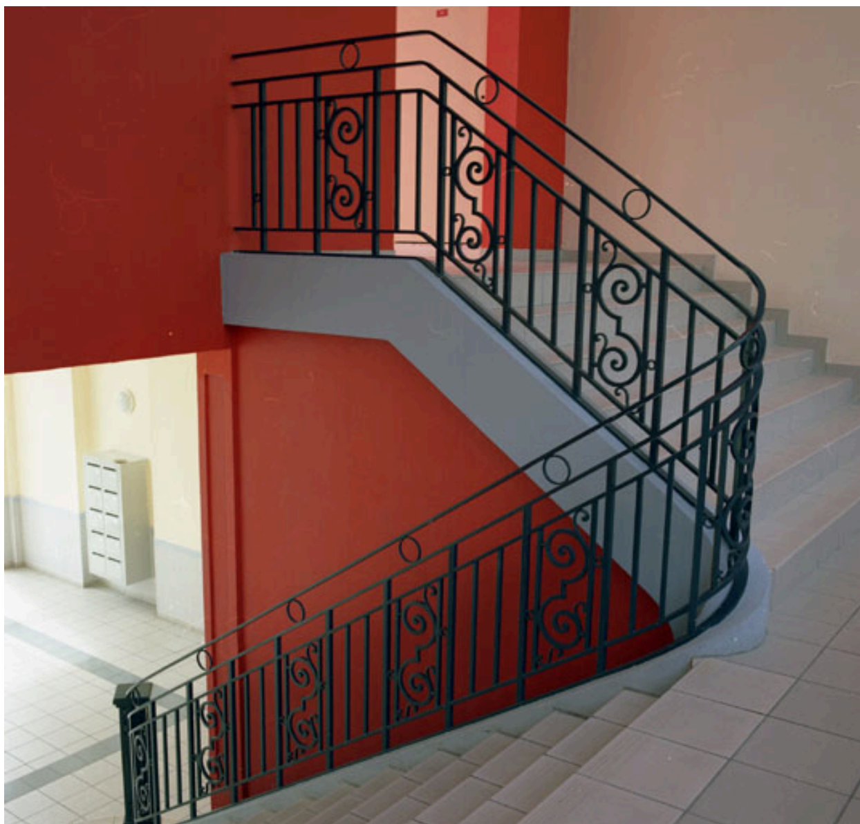
Intérieur, avant-corps, escalier monumental : volée droite et volée latérale, état en 2005 après réhabilitation.
