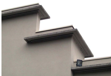
Façade arrière, avant-corps central, détail : traitement des rampants du fronton. Phot. Olivier Liardet IVR31_20065906164NUCA
