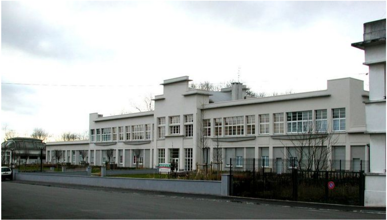
Façade principale, vue générale en 2005 après réhabilitation.
