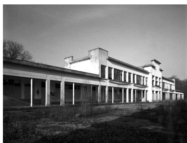
Façade principale, vue générale, état en 2001 avant réhabilitation en logements. Phot. Pierre Thibaut IVR31_20015900936V
