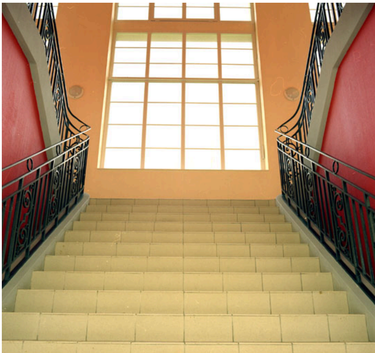
Intérieur, avant-corps, escalier monumental : volée droite et départ de la volée double, état en 2005 après réhabilitation.
