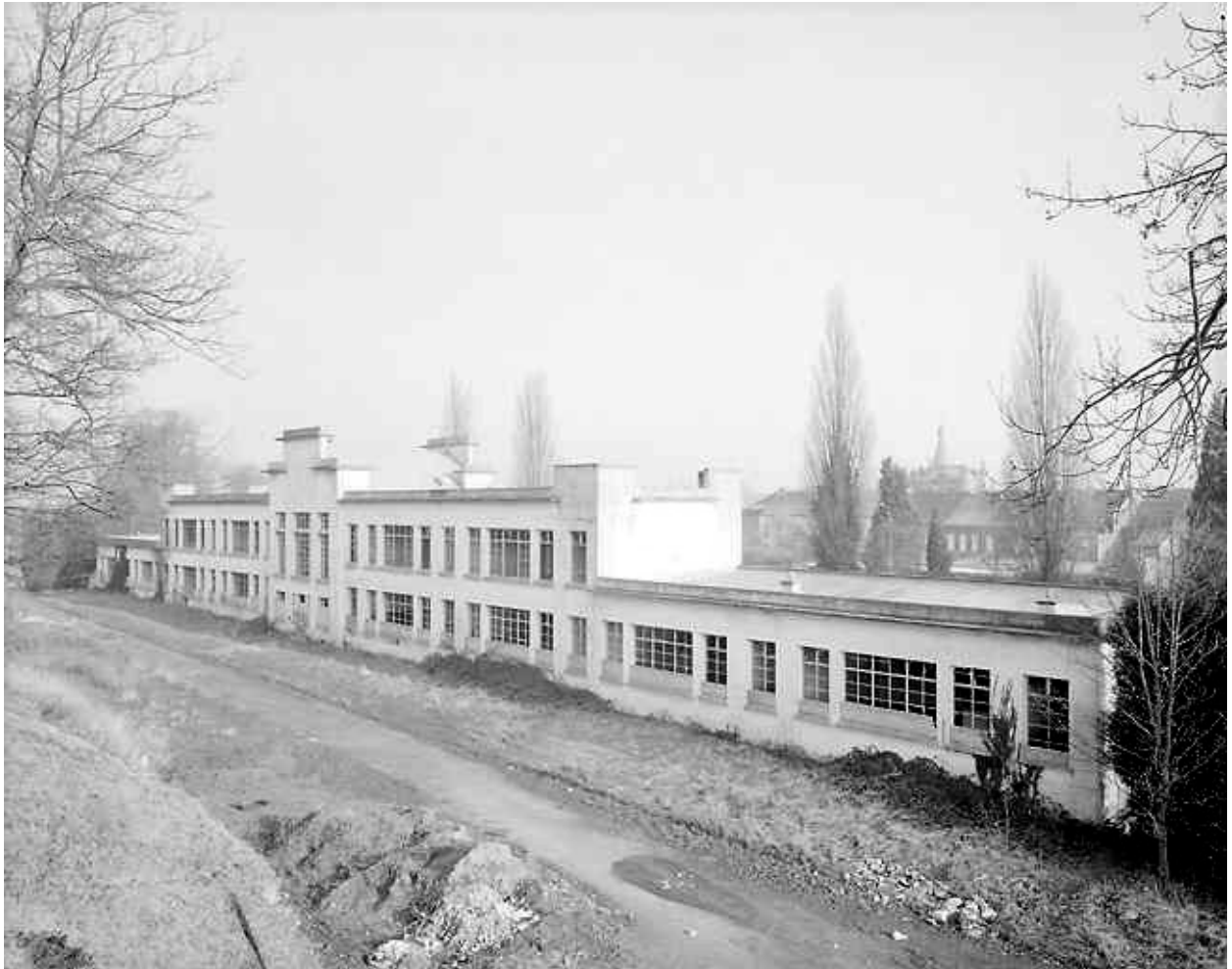
Façade arrière, vue générale, état en 2001 avant réhabilitation.
