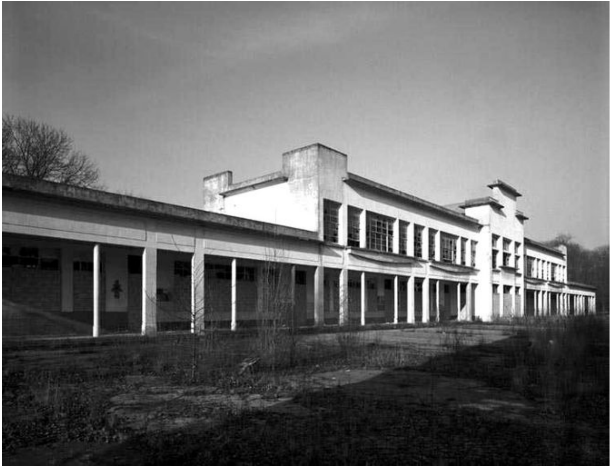
Façade principale, vue générale, état en 2001 avant réhabilitation en logements.
