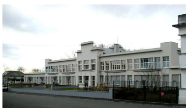
Façade principale, vue générale en 2005 après réhabilitation. Phot. Anita Oger-Leurent IVR31_20065906158NUCA
