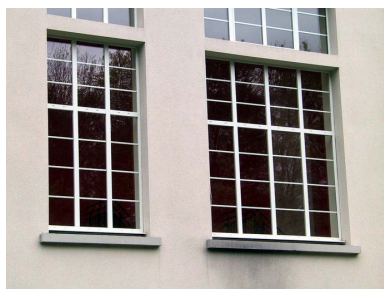
Façade arrière, avant-corps central, 1er étage, détail : baies. Phot. Olivier Liardet IVR31_20065906163NUCA
