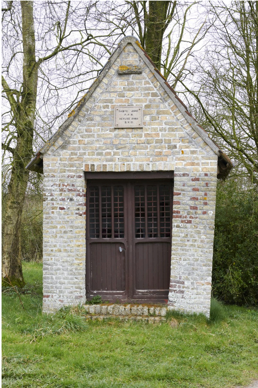
Façade principale de la chapelle.
