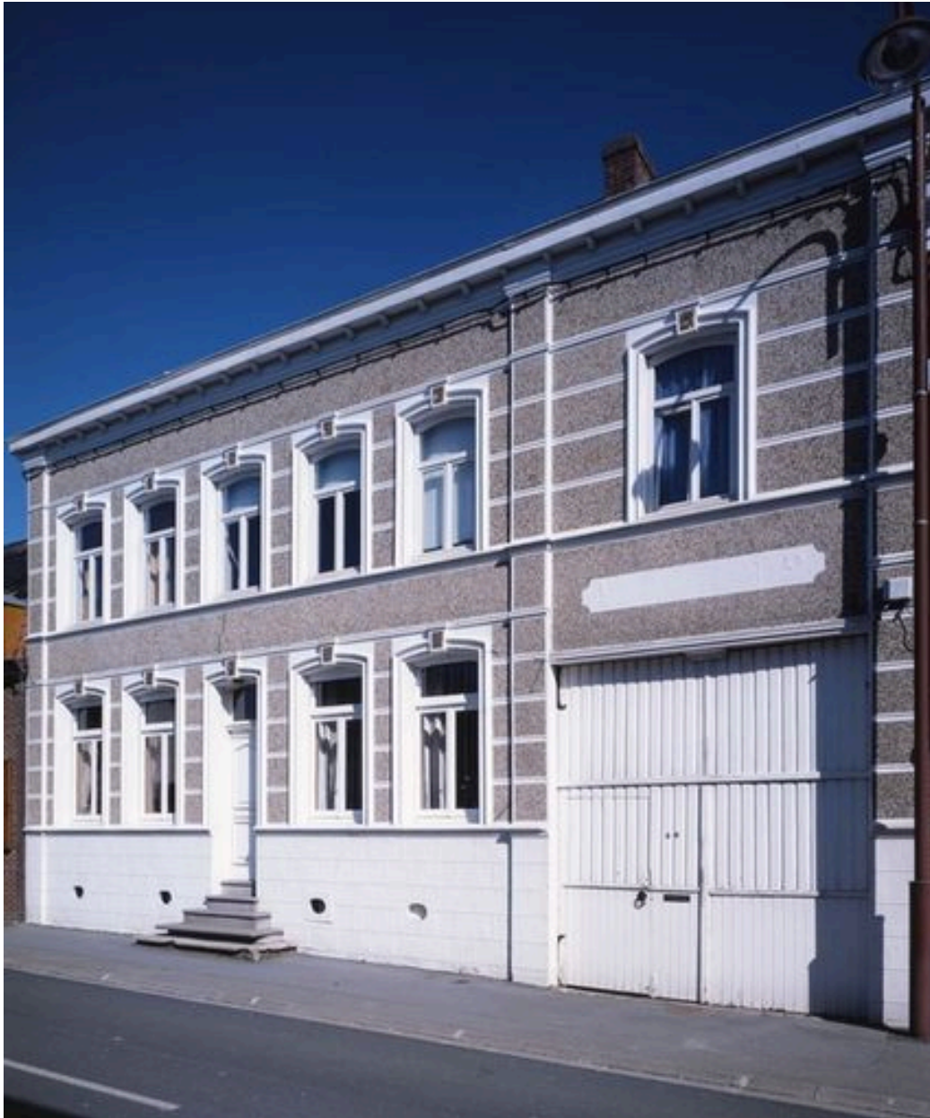
Vue générale de la brasserie.
