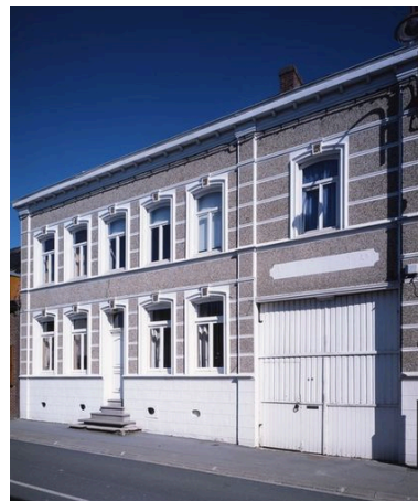
Vue générale de la brasserie. Phot. Pierre Thibaut IVR31_20095901347VA
