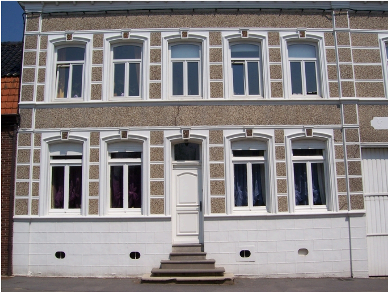
Vue générale de la façade.
