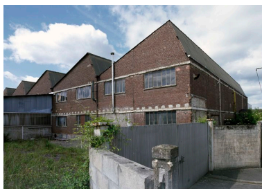
Ateliers de fabrication des postes de soudure. Phot. Thierry Lefebure IVR22_20106000408NUCA
