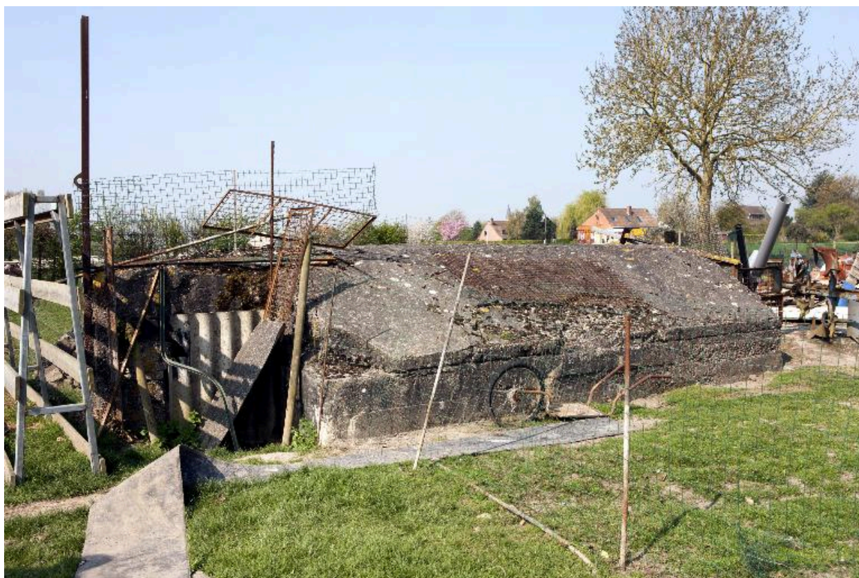
Casemate est, vers l'ouest
