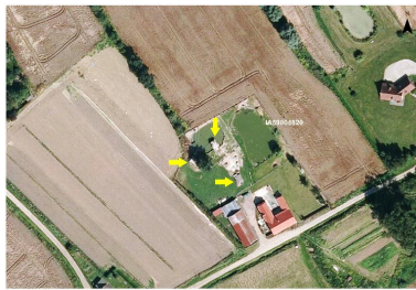
Situation des 3 casemates à personnel en 2014 Phot. Jean-Marc Ramette IVR32_20175900169NUCA
