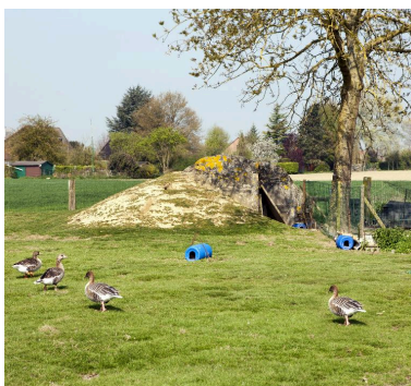
Casemate ouest, vers le nord-ouest Phot. Pierre Thibaut IVR31_20155901187NUCA
