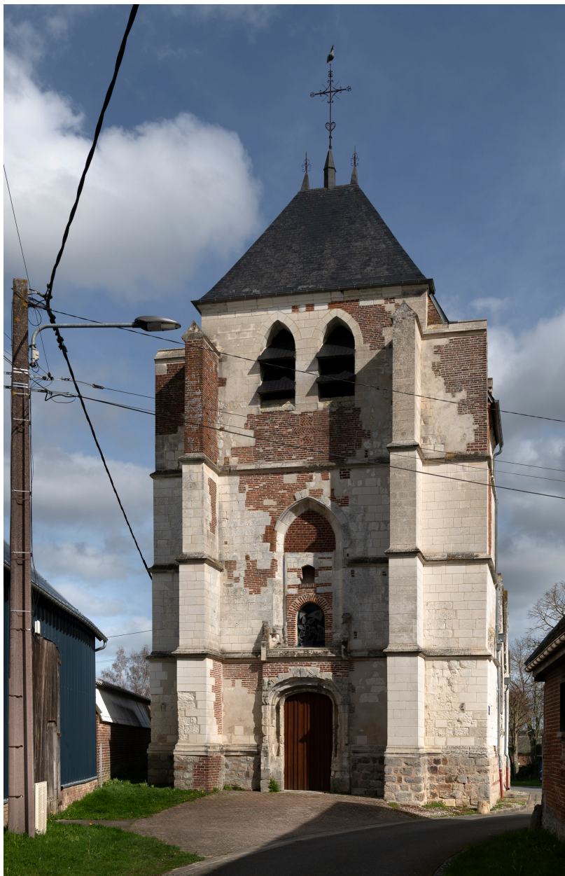
Vue générale de l'élévation occidentale du clocher.
