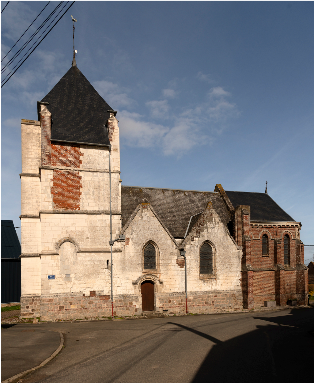
Vue de l'élévation sud de l'église Saint-Marc.
