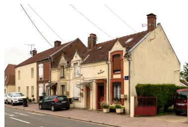
Anciens logements des ouvriers de l'usine Lecomte, n°4-10 rue Principale, vue depuis le nord-est. Phot. Marc Kérignard IVR32_20216000878NUCA
