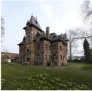
Vue de trois-quarts nord-ouest. Phot. Thierry Lefébure IVR22_20158000155NUC2AQ
