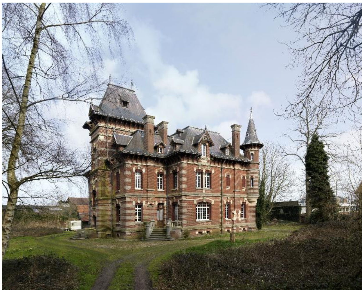
Vue de la façade occidentale.
