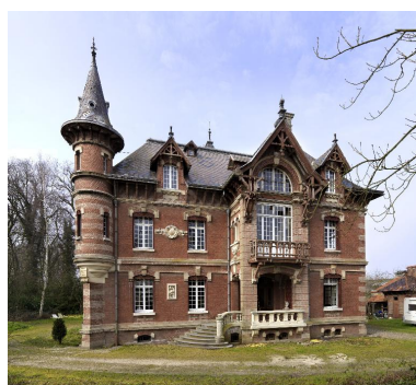
Façade antérieure. Phot. Thierry Lefébure IVR22_20158000153NUC2A
