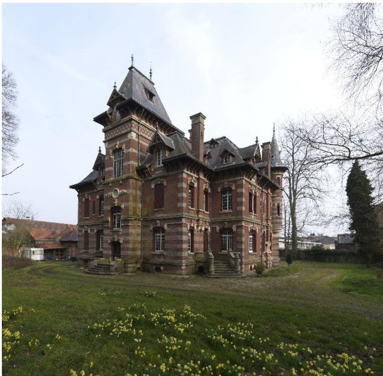
Vue de trois-quarts nord-ouest.
