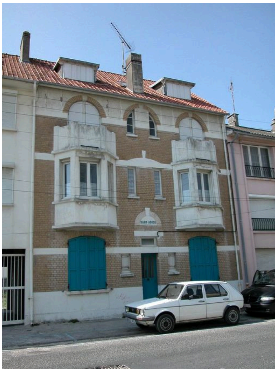
Bow-windows de l'immeuble Sans Adieu (108 Bd Intérieur).
