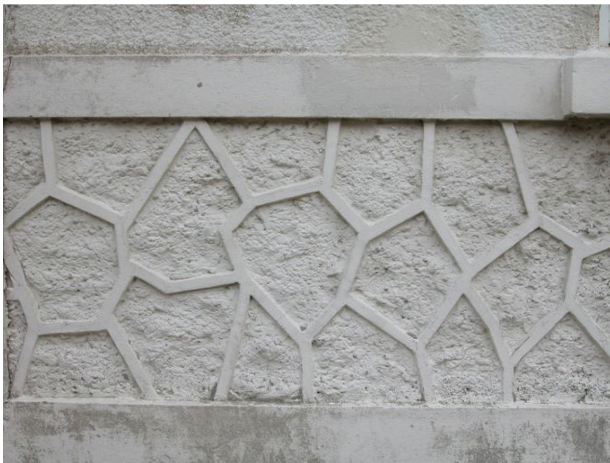
Détail de l'enduit imitant des moellons de pierre (L'Emeraude, 59 Bd Intérieur).
