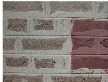
Détail de la mise en oeuvre de la façade. Phot. Elisabeth Justome IVR22_20058002877NUCA
