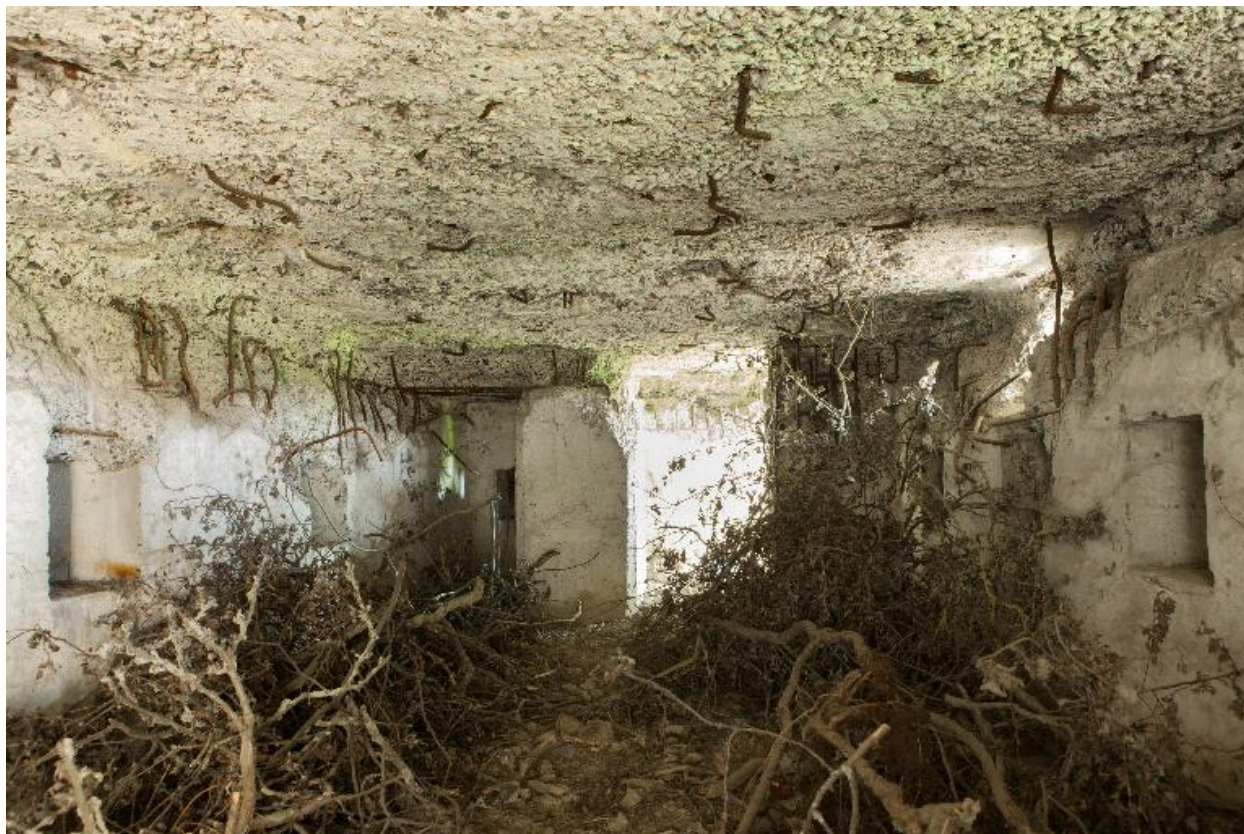
Vue intérieure, vers l'est
