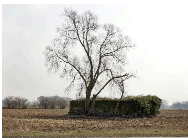
Elévation nord Phot. Jean-Marc Ramette IVR31_20145904024NUCA
