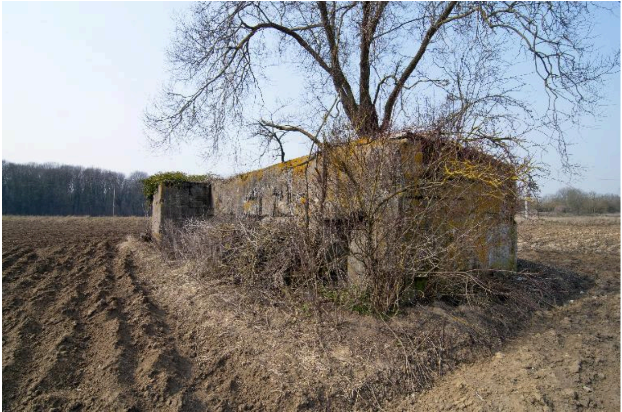
Vue générale, vers le nord-ouest
