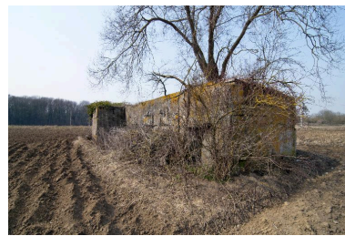
Vue générale, vers le nord-ouest Phot. Jean-Marc Ramette IVR31_20145904035NUCA
