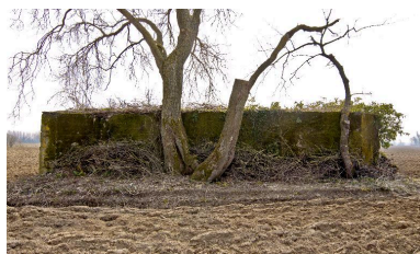
Elévation nord Phot. Jean-Marc Ramette IVR31_20145904033NUCA
