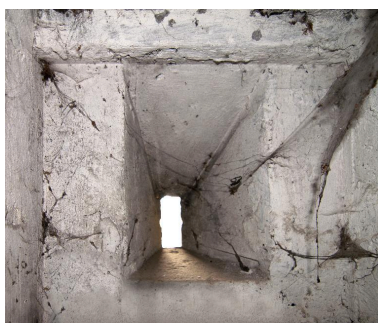
Coursière de tir, détail d'un créneau de fusillade Phot. Jean-Marc Ramette IVR31_20145904038NUCA
