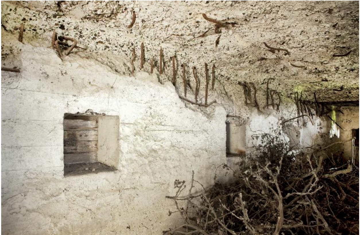
Vue intérieure, niches à munitions
