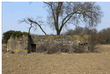
Elévation sud Phot. Jean-Marc Ramette IVR31_20145904029NUCA
