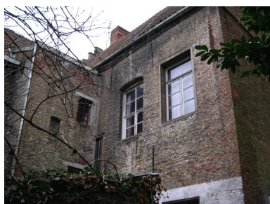
Façade arrière, vue partielle : étage. Phot. Anita Oger-Leurent IVR31_20065906106NUCA
