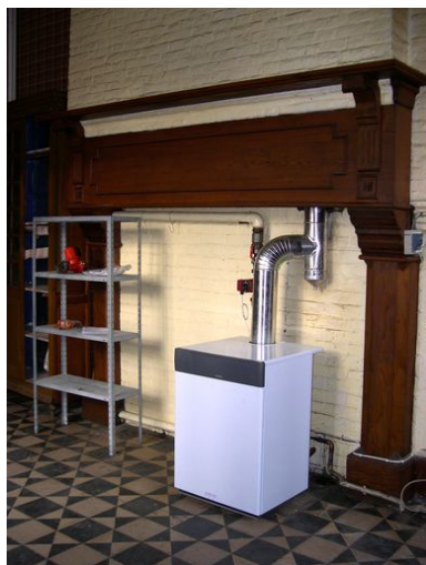
Intérieur, rez-de-chaussée, pièce sud-est : manteau de cheminée. Phot. Anita Oger-Leurent IVR31_20065906115NUCA
