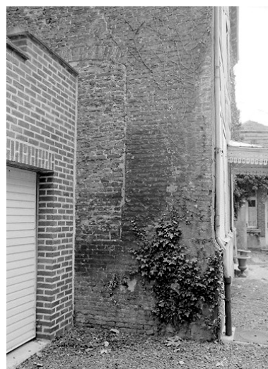
Mur pignon côté nord-ouest, vue partielle : baie condamnée comprenant un ébrasement chanfreiné ; solin de façade taluté en pierre. Phot. Pierre Thibaut IVR31_20035900967X
