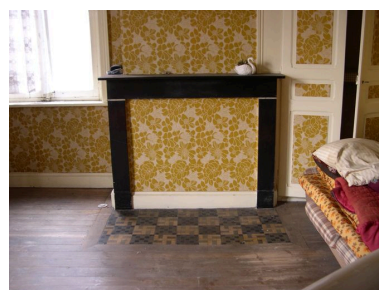
Intérieur, premier étage, pièce sud-ouest, vue partielle : cheminée. Phot. Anita Oger-Leurent IVR31_20065906122NUCA
