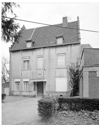
Élévation principale côté place Saint-Wasnon. Phot. Pierre Thibaut IVR31_20015901082V
