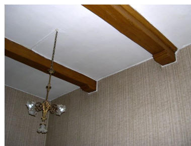
Intérieur, rez-de-chaussée, pièce nord-est : plafond, vue partielle, abouts de poutres moulurés. Phot. Anita Oger-Leurent IVR31_20065906119NUCA
