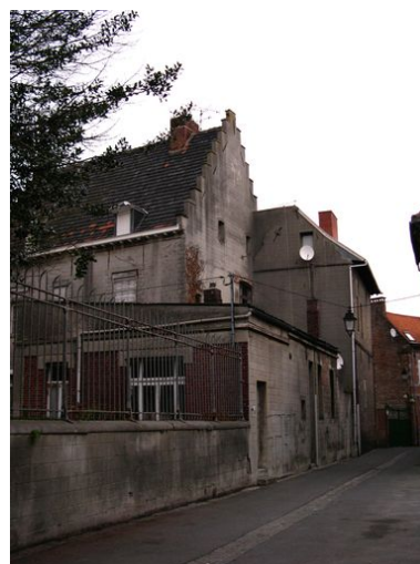
Vue de l'édifice depuis la rue Dervaux. Au premier plan, corps de bâtiment en rez-de-chaussée adjoit dans les années 1930. Phot. Anita Oger-Leurent IVR31_20065906108NUCA
