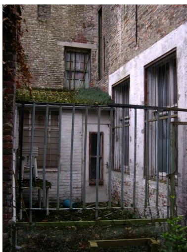
Façade arrière, vue partielle : rez-de-chaussée, courrette. Phot. Anita Oger-Leurent IVR31_20065906107NUCA
