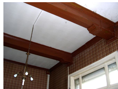
Intérieur, rez-de-chaussée, pièce sud-est : plafond, vue partielle, abouts de poutres moulurés. Phot. Anita Oger-Leurent IVR31_20065906117NUCA
