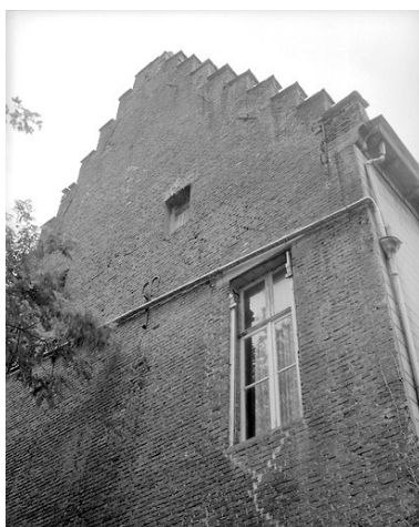
Mur pignon côté nord-ouest : détail, vue de la partie supérieure. Phot. Pierre Thibaut IVR31_20035900968X
