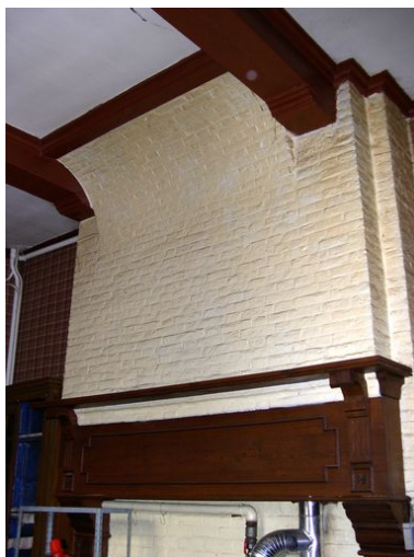
Intérieur, rez-de-chaussée, pièce sud-est : trumeau de cheminée. Phot. Anita Oger-Leurent IVR31_20065906116NUCA
