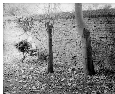
Jardin, mur de clôture en mitoyenneté avec le terrain de l'ancien cimetière, vue partielle : porte condamnée (à gauche) ; au ras du sol, date dessinée par des briques en saillie : 1732. Phot. Pierre Thibaut IVR31_20035900970X
