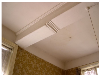
Intérieur, premier étage, pièce sud-ouest : plafond, vue partielle, about de poutre mouluré. Phot. Anita Oger-Leurent IVR31_20065906123NUCA
