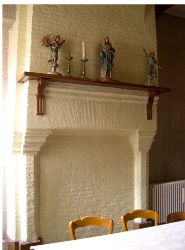
Intérieur, rez-de-chaussée, pièce nord-est : manteau de cheminée. Phot. Anita Oger-Leurent IVR31_20065906118NUCA
