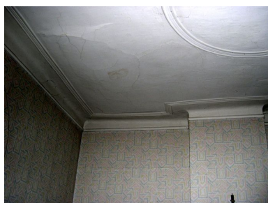
Intérieur, rez-de-chaussée, pièce nord-ouest : plafond, vue partielle. Phot. Anita Oger-Leurent IVR31_20065906114NUCA
