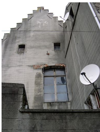
Façade latérale sud-est, vue partielle : pignon à redents, baie de la salle des bateliers. Phot. Anita Oger-Leurent IVR31_20065906109NUCA
