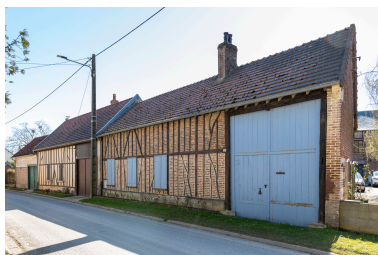
Logis sur rue et entrée charretière, n°12 de la rue Principale, vue depuis le nord. Phot. Marc Kérignard IVR32_2025600099NUCA
