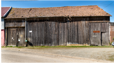
Grange sur rue, essentée de bois, n°8 de la rue la Ruellette, vue depuis l'est.
