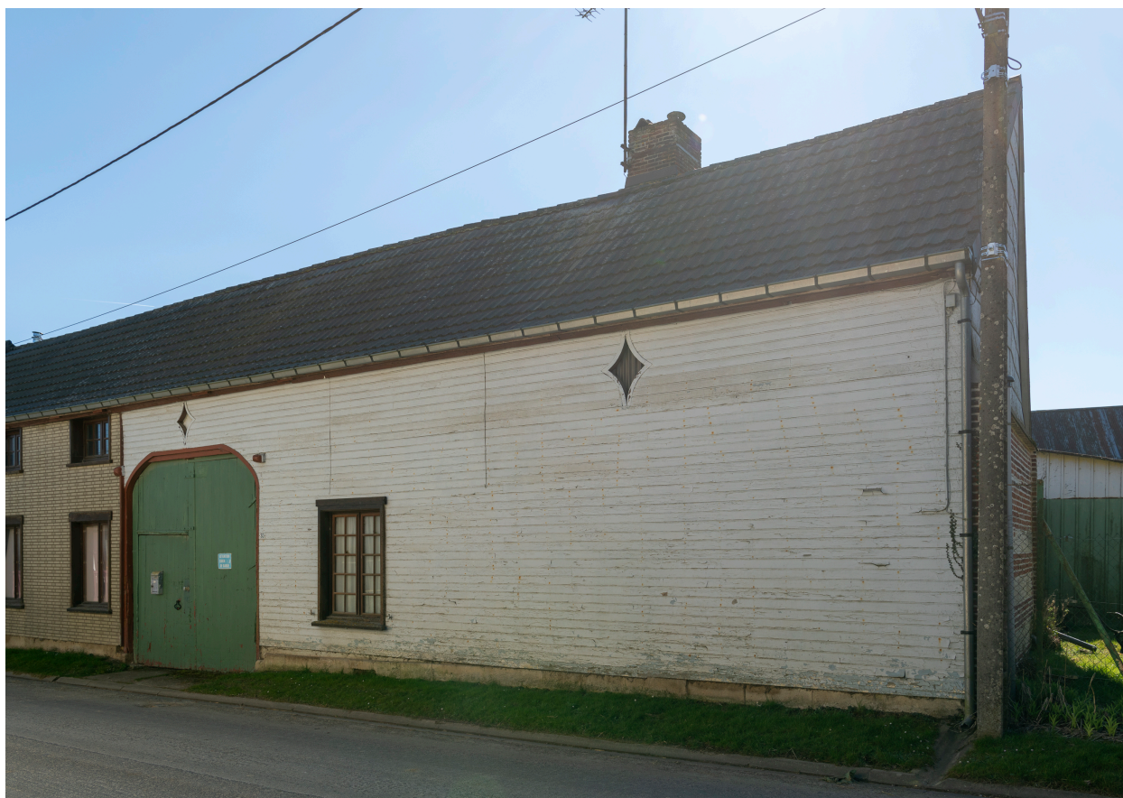
Ancienne grange sur rue (?) essentée de bois, n°30 de la rue Principale, vue depuis le nord.
