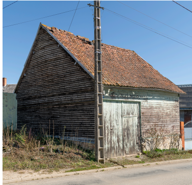
Entrée charretière essentée de bois, n°4 de la rue Blanche, vue depuis l'ouest.
