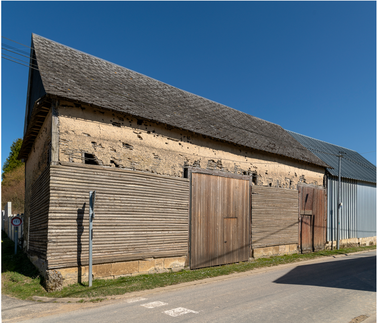
Grange sur rue avec deux portes charretières, n°17 de la rue Principale, vue depuis le sud.
