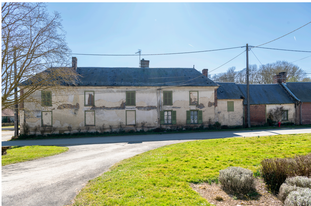
Logis de ferme, n°38 de la rue Principale, vue depuis le nord.
