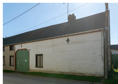
Ancienne grange sur rue (?) essentée de bois, n°30 de la rue Principale, vue depuis le nord. Phot. Marc Kérignard IVR32_20256000088NUCA
