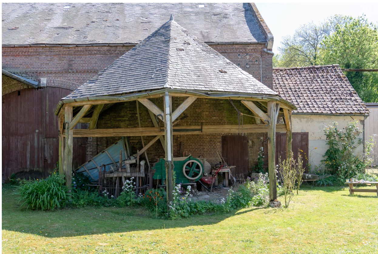
Ancien manège à chevaux, ferme au n°38 de la rue Principale, vue depuis le nord.
