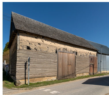
Grange sur rue avec deux portes charretières, n°17 de la rue Principale, vue depuis le sud. Phot. Marc Kérignard IVR32_20256000105NUCA
