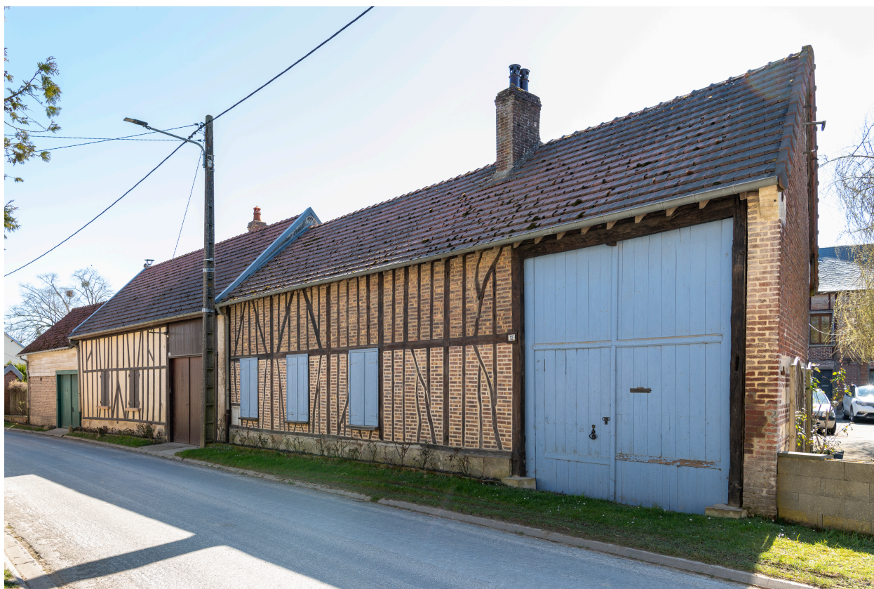
Logis sur rue et entrée charretière, n°12 de la rue Principale, vue depuis le nord.
