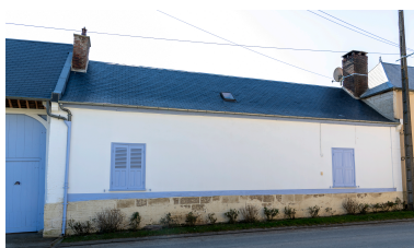
Logis sur rue d'une ancienne ferme, n°24 de la rue Principale, vue depuis le nord. Phot. Marc Kérignard IVR32_20256000096NUCA
