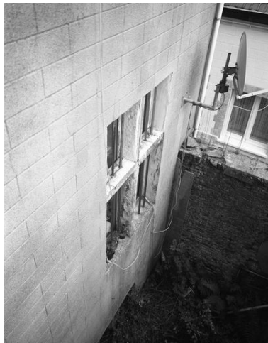
Mur sud-est en retour de façade, détail : baie à traverse et meneau de pierre. Phot. Pierre Thibaut IVR31_20035900975X
