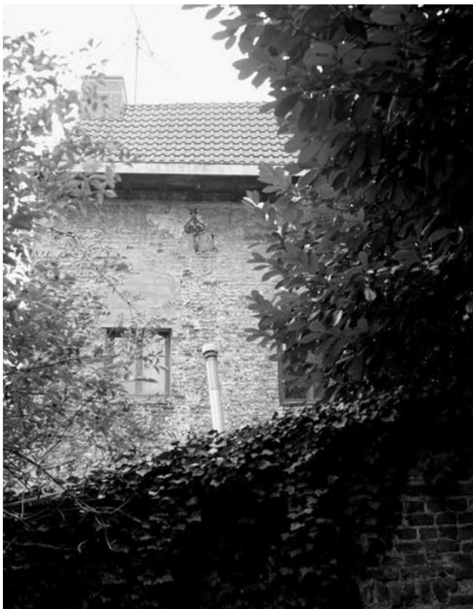
Façade arrière : vue partielle.
