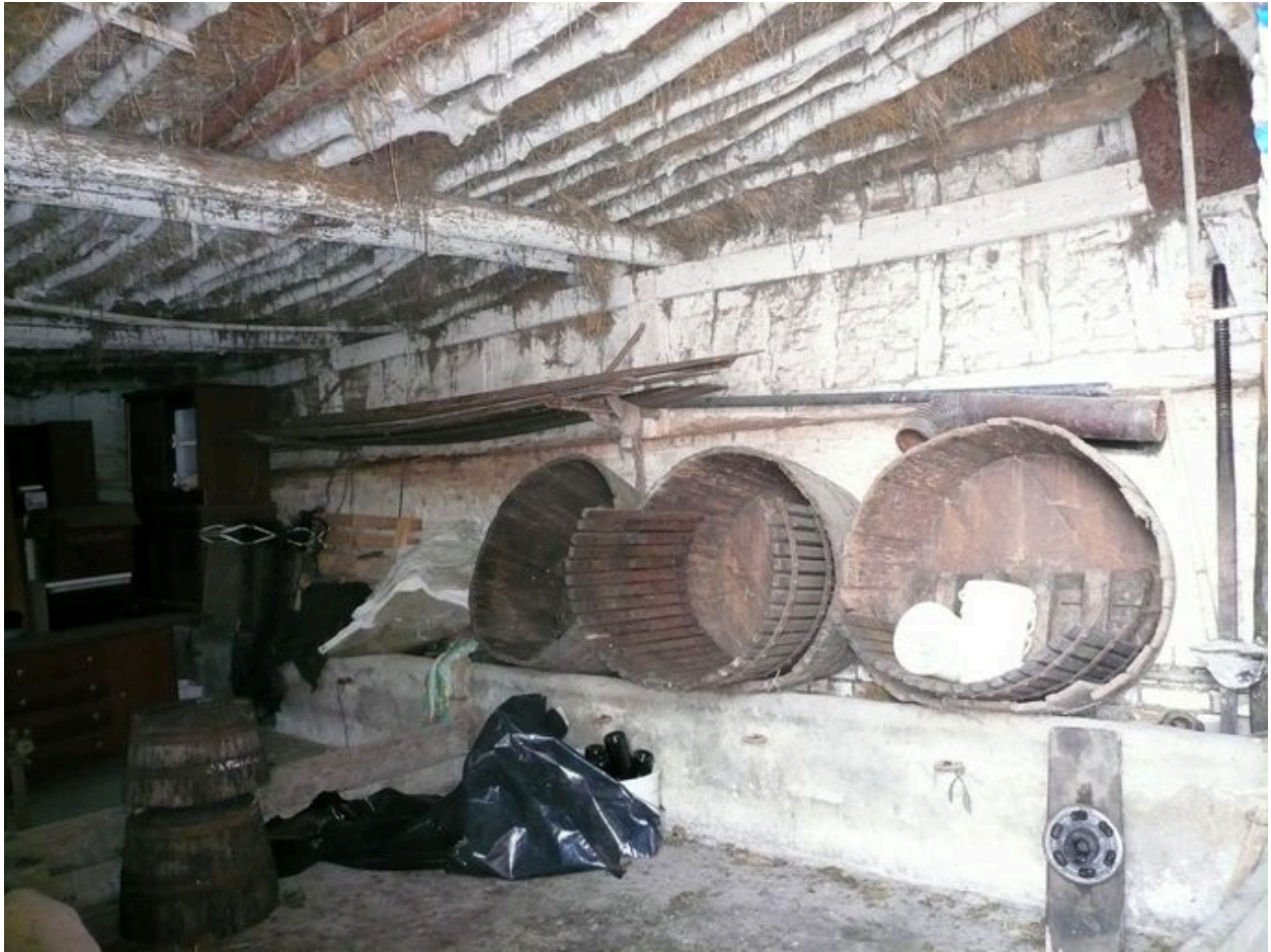
Vue intérieure de la partie étable située dans la grange.
