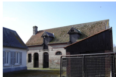
Vue des écuries. Phot. Inès Guérin IVR22_20058005465NUCA
