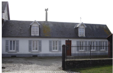
Vue du logis. Phot. Inès Guérin IVR22_20058005463NUCA
