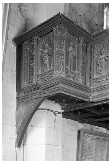
Angle gauche du garde-corps, chêne, XVIe siècle. Phot. Thierry Lefébure IVR22_19940200945X
