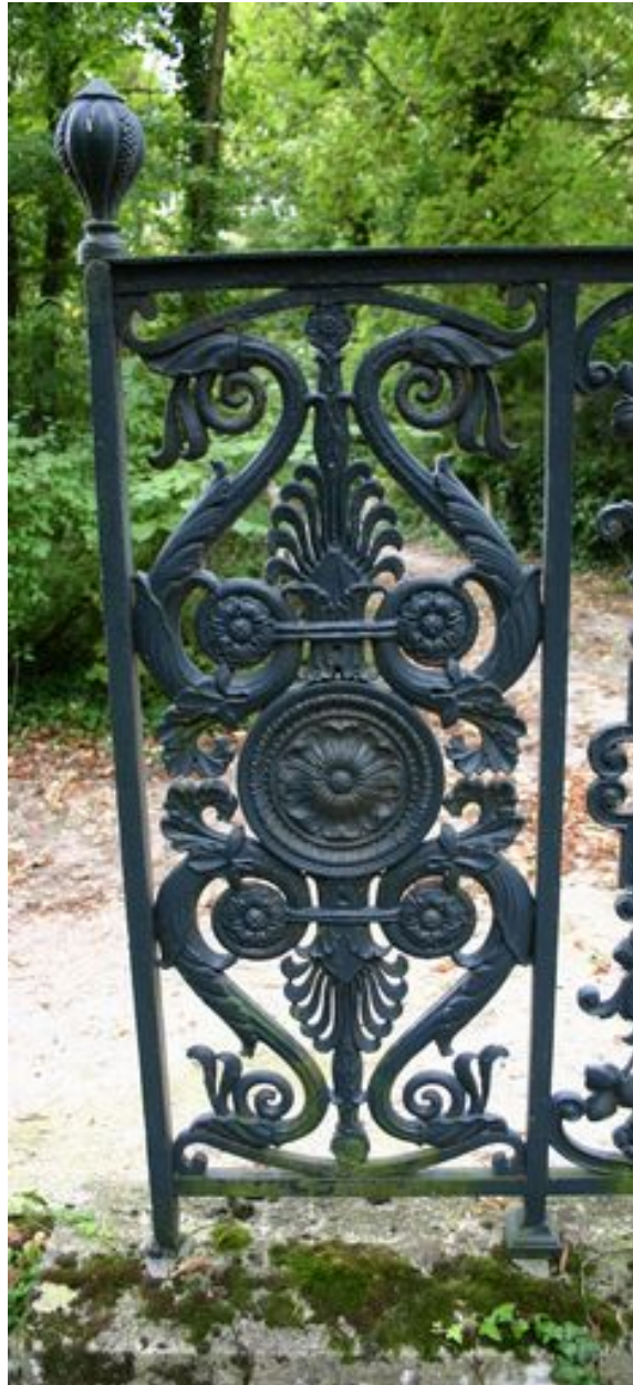
Détail de la grille de clôture ouvragée : face postérieure.
