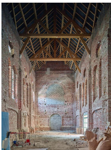
Vue générale de la nef, depuis le chœur. Phot. Pierre Thibaut IVR32_20166200289NUCA
