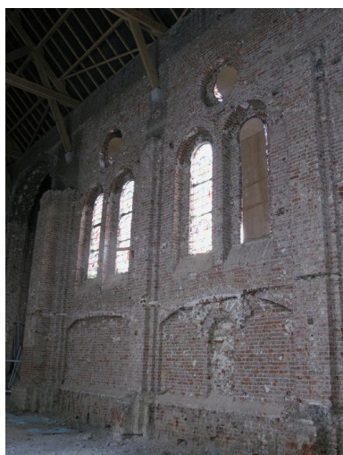
Mur sud de la nef Phot. Bruno Decrock IVR31_20126201579NUCA
