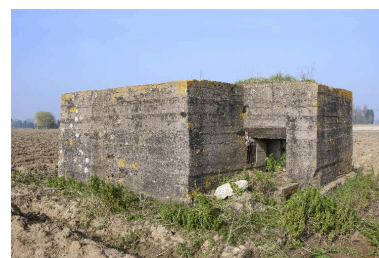
Vue de trois-quarts vers le nord-est. Phot. Jean-Marc Ramette IVR31_20145905450NUCA
