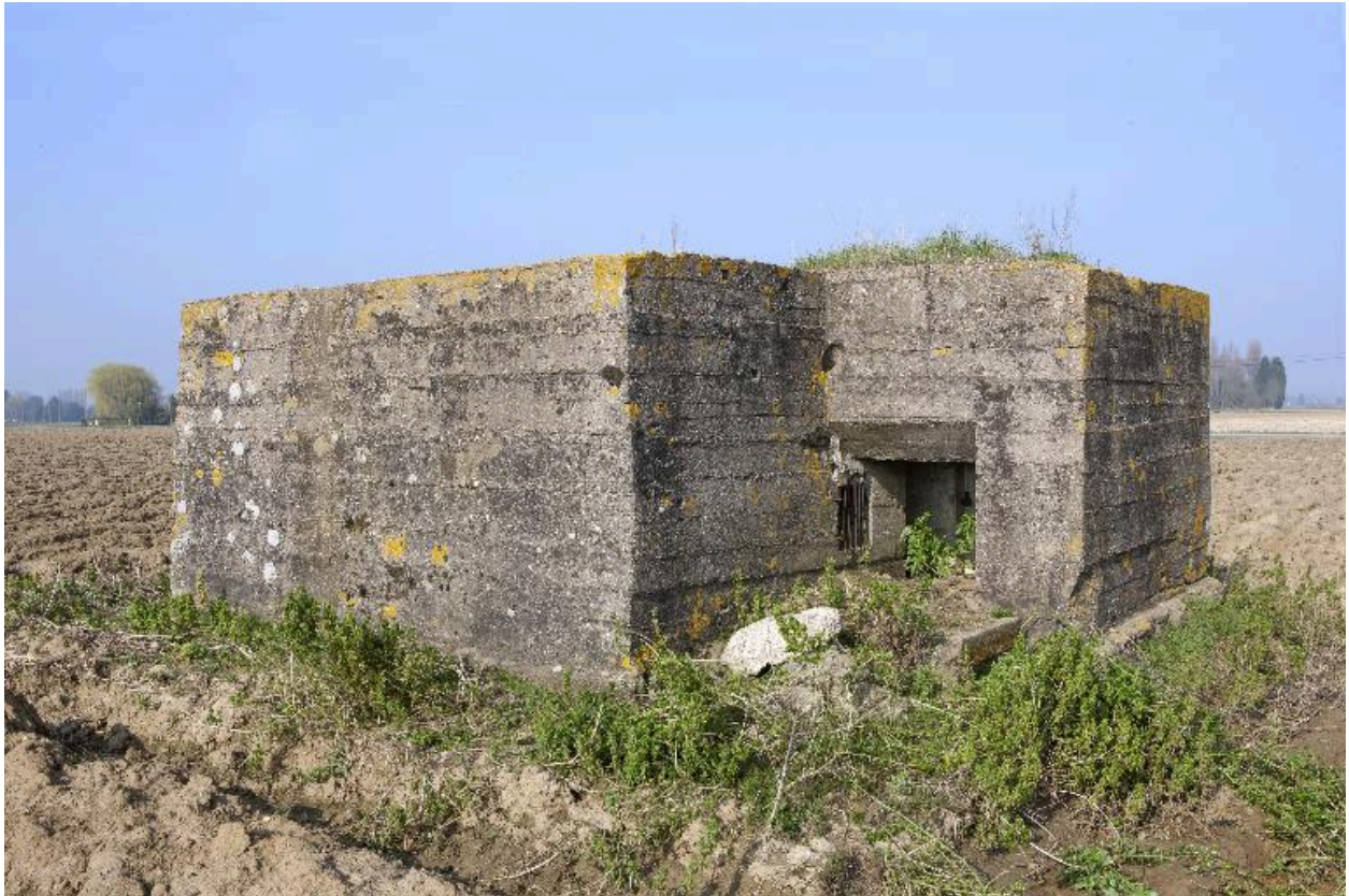
Vue de trois-quarts vers le nord-est.
