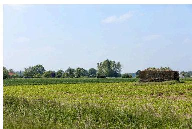
Vue générale, vers le sud-ouest Phot. Jean-Marc Ramette IVR31_20145906014NUCA
