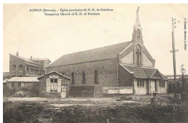
Albert (Somme). Eglise provisoire de Notre-Dame de Brebières. Carte postale, vers 1925 (coll. part.). IVR32_20218005006NUCA
