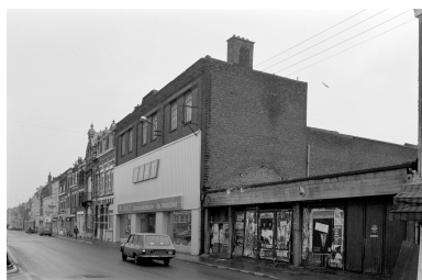
Élévation antérieure, rue des Déportés. Phot. Philippe Dapvril IVR31_19885902322Z
