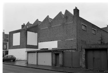
Élévation postérieure rue Jeanne-d'Arc. Phot. Olivier Marlard IVR31_19885902320Z
