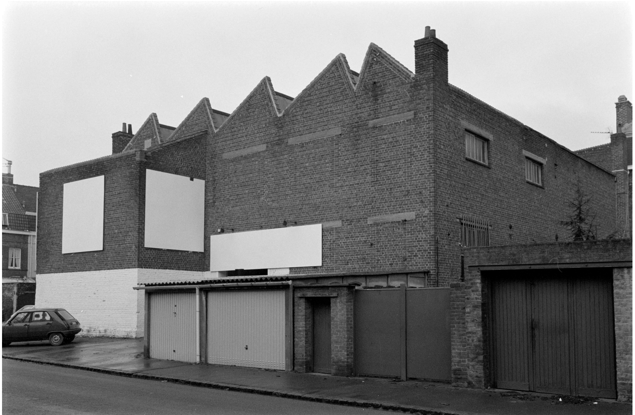
Élévation postérieure rue Jeanne-d'Arc.
