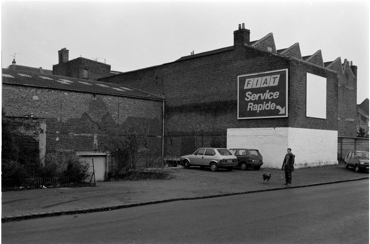
Atelier de fabrication, élévation rue Gustave-Dron.
