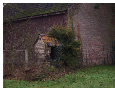
Vue générale du puits I. Phot. Cyril Cailleau IVR31_20045905422NUC
