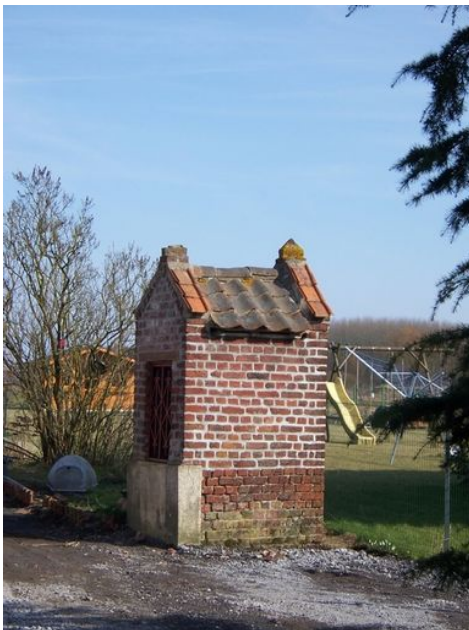
Vue générale du puits H.
