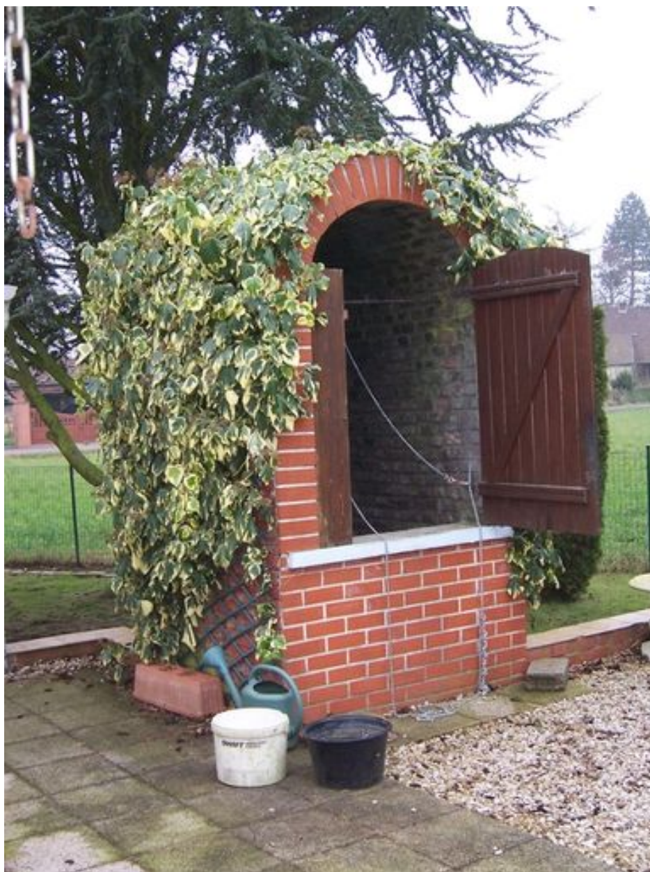
Vue générale du puits E.
