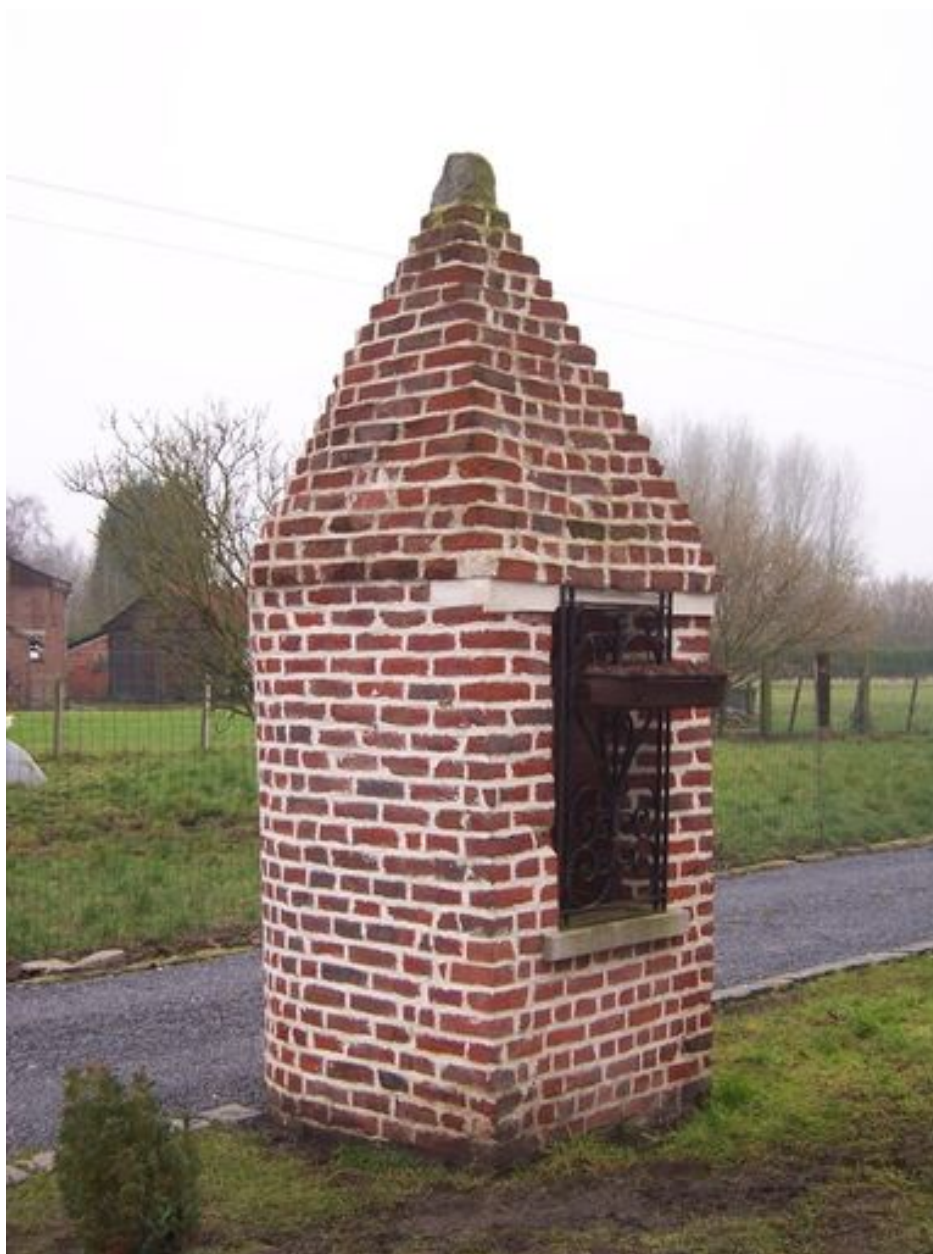
Vue générale du puits F.
