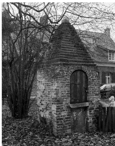
Vue générale du puits A. Phot. Philippe Dapvril IVR31_20045901120X
