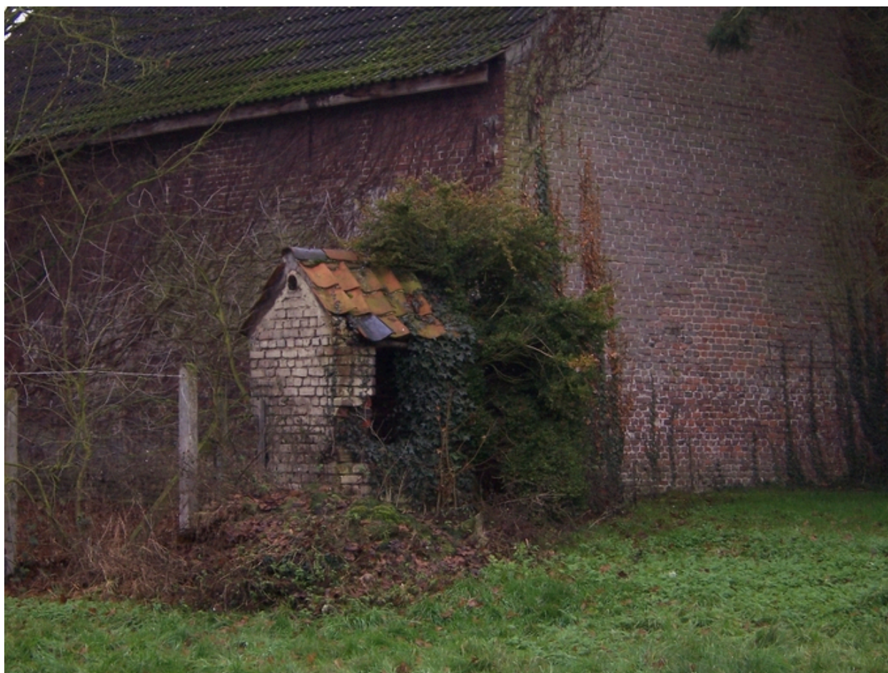
Vue générale du puits I.
