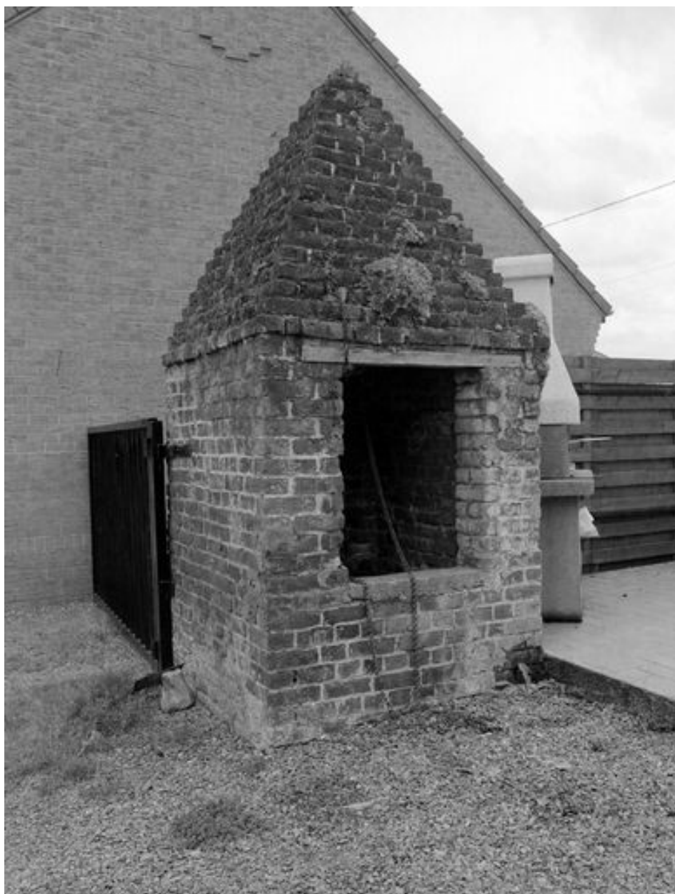
Vue générale du puits G.
