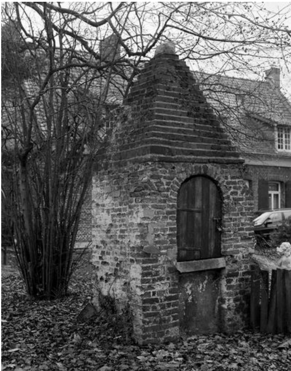
Vue générale du puits A.
