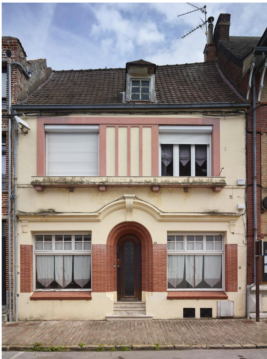
Maison : vue de la façade principale sur la rue de l'Aulette.
