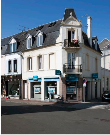
Vue générale. Phot. Pierre Thibaut IVR31_20146202236NUCA
